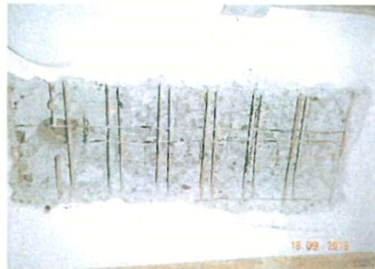
Hierbei bestätigten sich die anfänglichen Bedenken, was zum Anlass gab, die Materialprüfanstalt, Neuwied mit Probebohrungen und anschließender Materialprüfung zu beauftragen. Die Decke wurde sofort mit Baustützen und Trägern gesichert.
