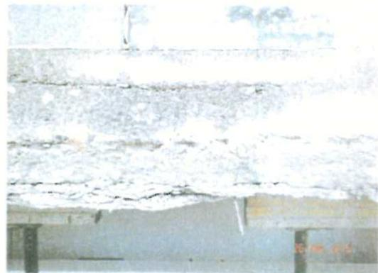
Der Statiker bestätigte dieses, woraufhin ein Probeschlitz von ca. 100 x 50cm in der Decke hergestellt wurde. Dieser diente erstens zum Ausschluss der Tatsache, dass die Decke nur aufgrund des Trennschnittes an der Schnittkante so aussah und zweitens um die Betonüberdeckung sowie die Maschenweite der Bewehrung zu messen.
