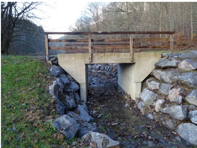
Abbildung 32: Barrierefreiheit für Bachlebewesen - an ausgewählten Bachläufen wurden die vorhandenen Rohr-Überfahrten durch Brücken ersetzt.
