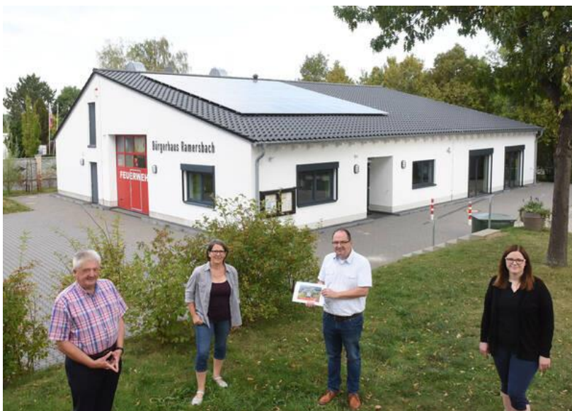
Abbildung 22: PV-Anlage auf dem Bürgerhaus in Ramersbach. Foto: Bad Neuenahr-Ahrweiler
