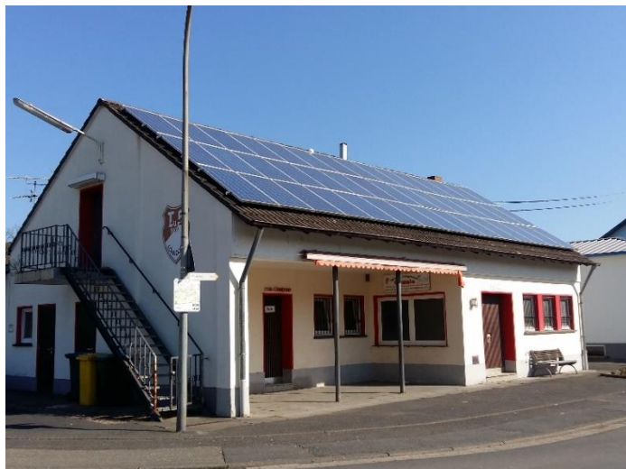
Abbildung 24: Photovoltaik-Anlage in Löhndorf. Foto: Stadt Sinzig
