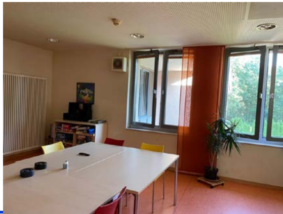
Fensterlüftungssystem mit einfachem Abluftventilator
