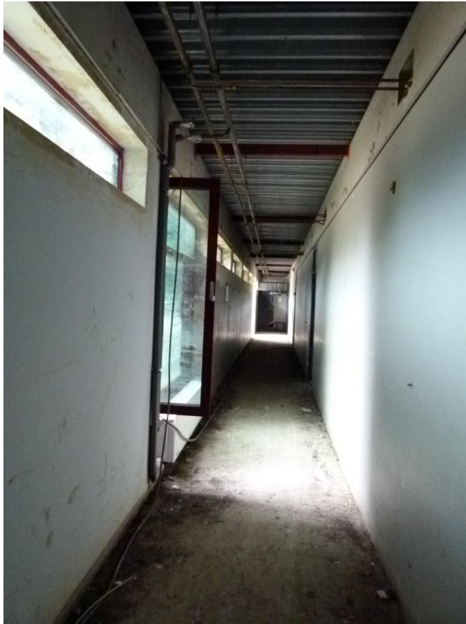
Foto 8 innere und äußere Stahlbetonwände
