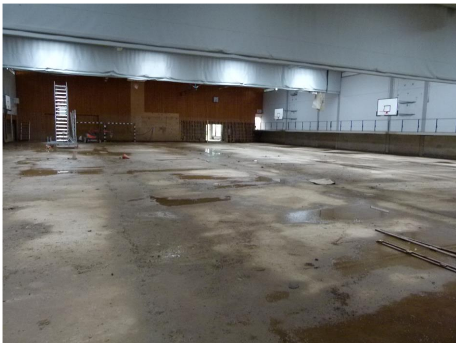
Foto 7 Zustand Sporthalle nach der Entkernung
