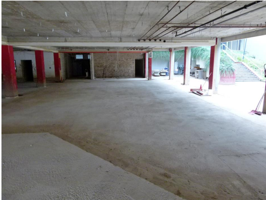
Foto 2 Innenbereich / Blick Richtung Süden
