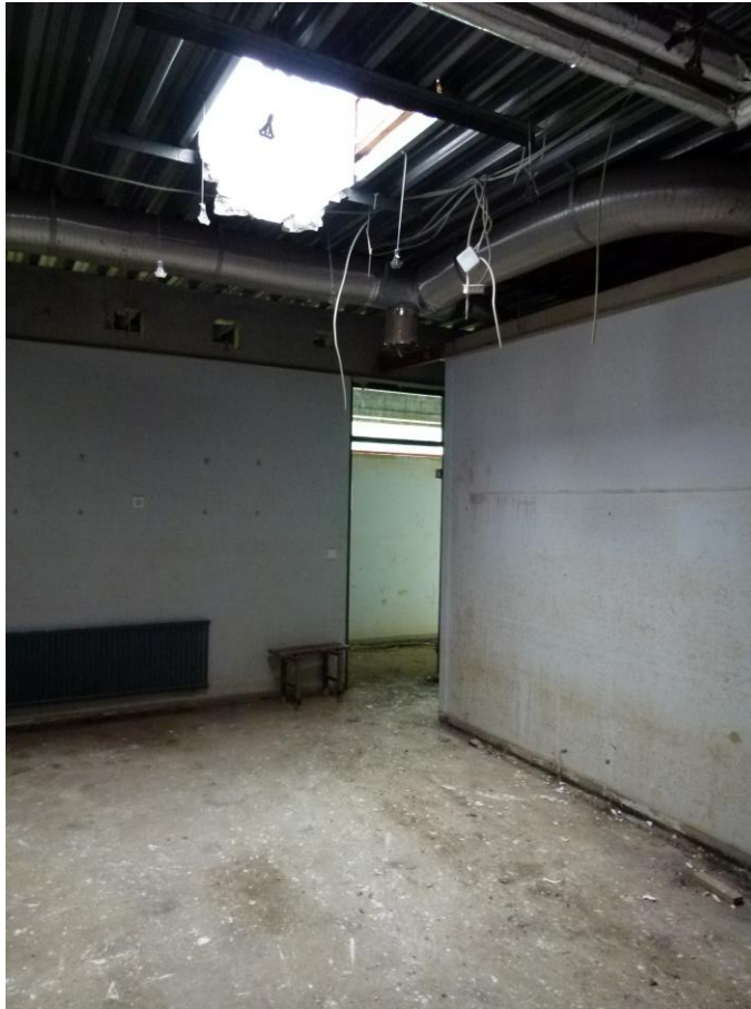
Foto 9 Zustand nach Ausbau von Boden- und Deckenkonstruktion
