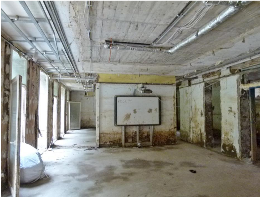
Foto 29 HS 1 - Unterrichtsraum südlicher Gebäudetrakt mit Blick Richtung Westen
