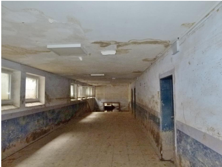
Foto 30 HS 1 - Flur unterhalb Eingangshalle mit Blick Richtung Norden
