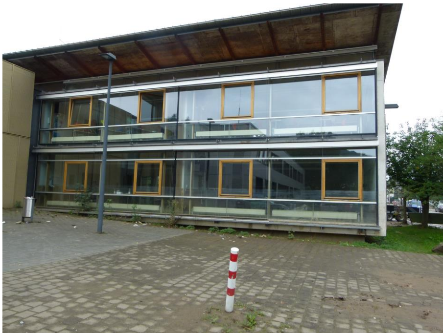
Foto 12 HS 2 - Südfassade nördlich des Verbindungsganges zu Haus 4
