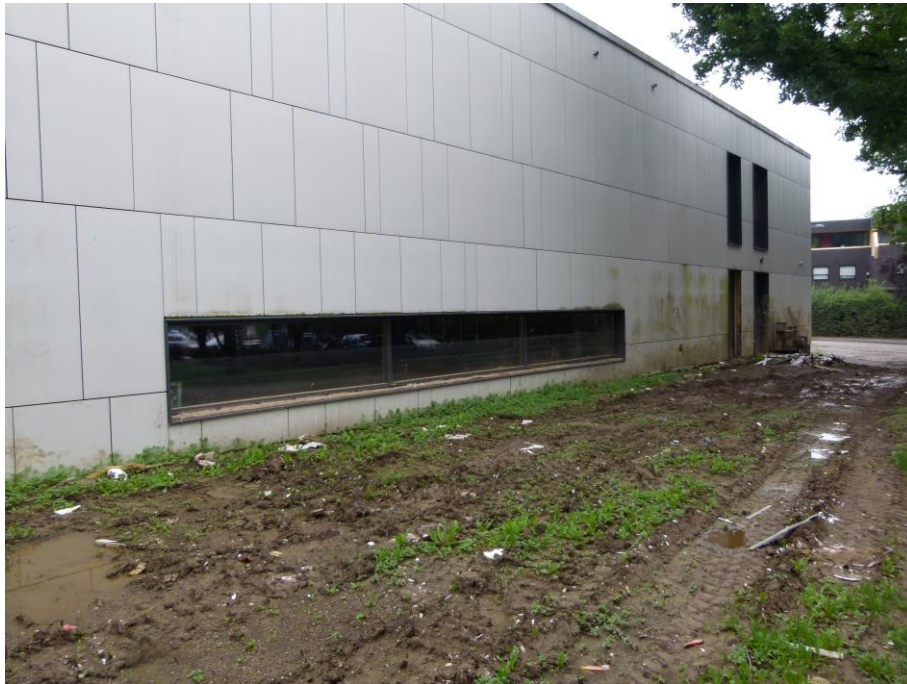
Foto 9 HS 4 - Ostfassade mit großformatigen Platten
