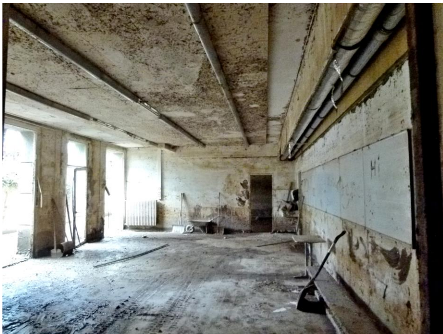
Foto 28 HS 1 - Abhängedecke westlicher Unterrichtsraum mit Blick Richtung Norden
