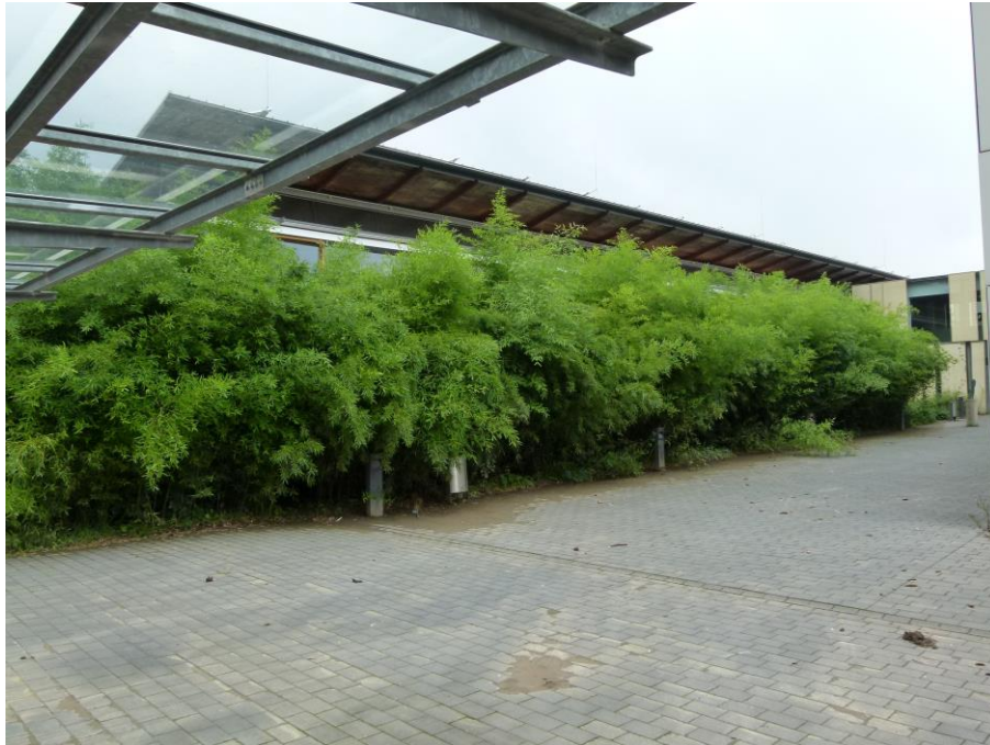
Foto 18 Bewuchs vor der Ost- bzw. Südfassade des Hauses 2
