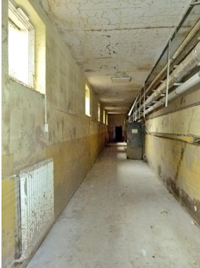
Foto 26 HS 1 - Zustand Nordflur mit Blick Richtung Osten
