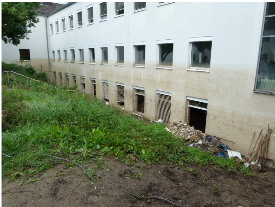
Foto 25 HS 1 - Südfassade Innenhof mit Blick Richtung Westen
