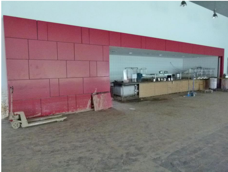
Foto 41 HS 4 - Ausgabe Mensa mit Blick Richtung Nordosten
