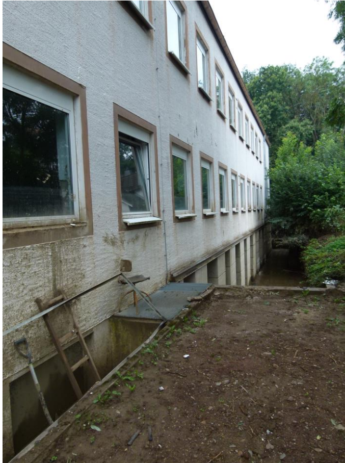
Foto 2 Westfassade im Bereich der Lichtschächte
