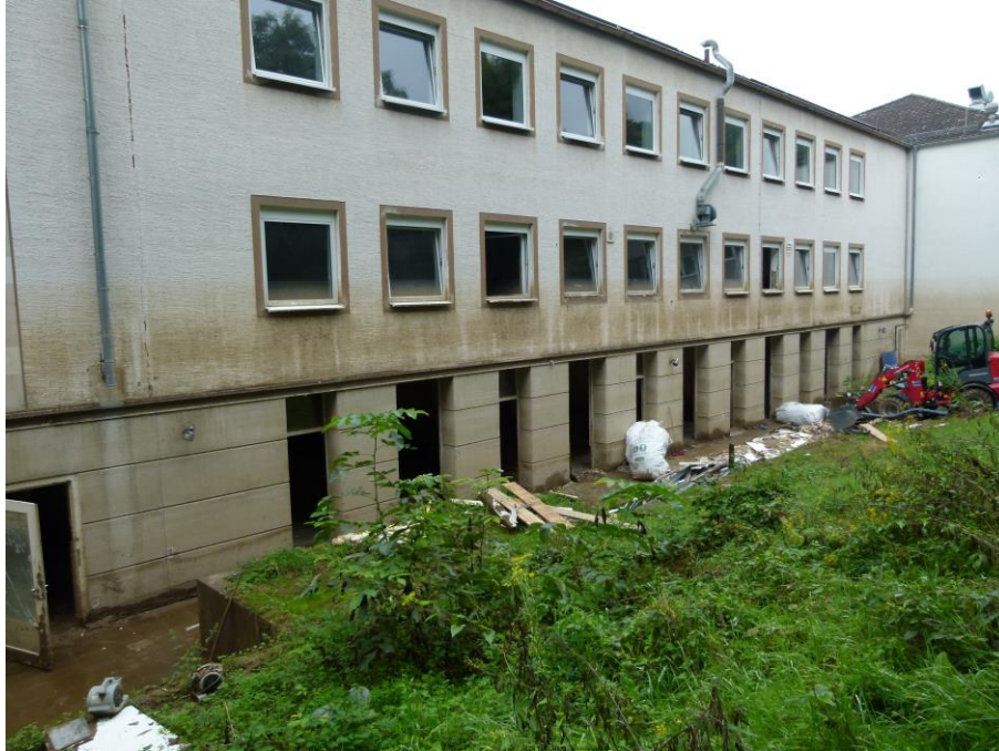
Foto 3 dreigeschossiger Teil Westfassade
