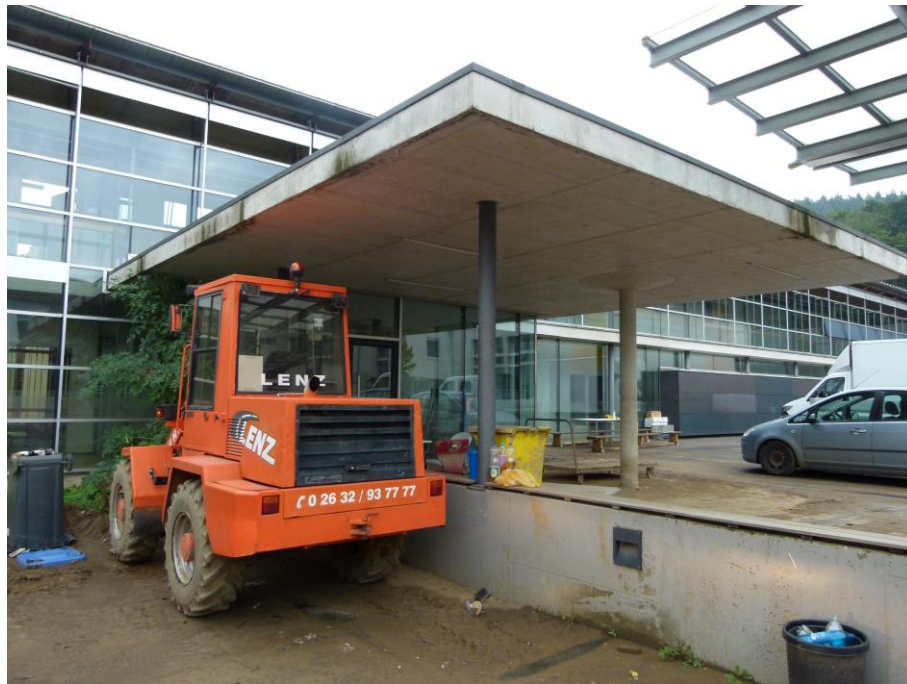
Foto 14 HS 2 - Westfassade Bereich Unterrichtsräume mit Blick Richtung Süden
