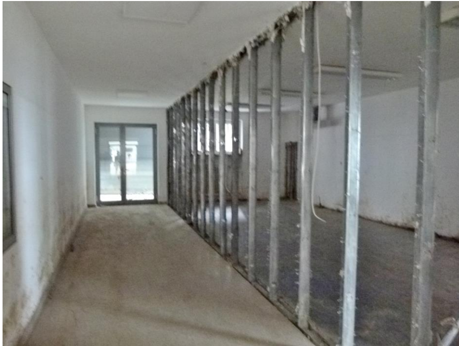
Foto 21 HS 1 Flur zum Haus 3 mit Blick Richtung Süden
