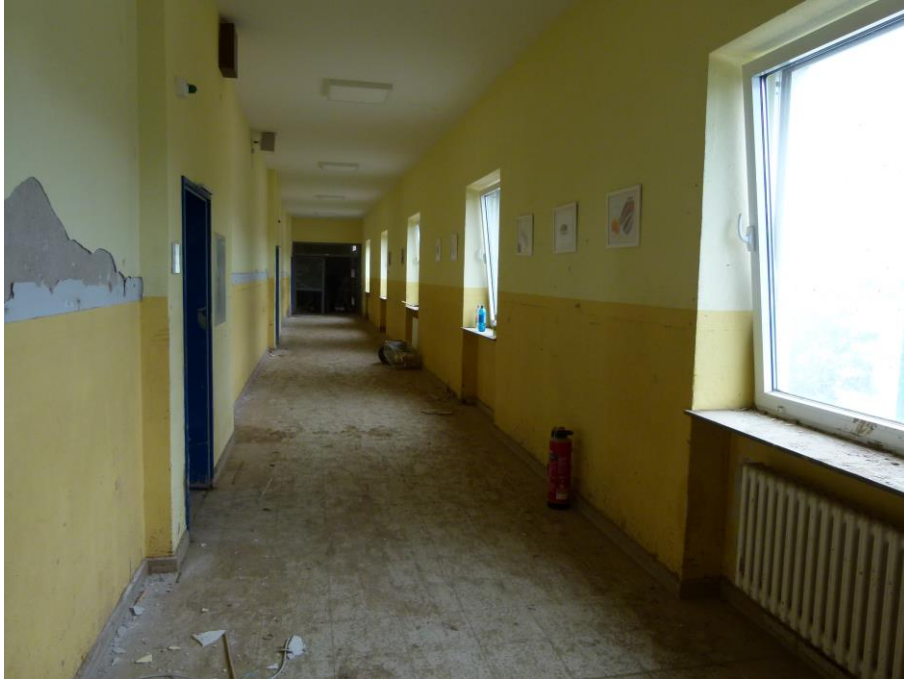
Foto 19 HS 1 - Zustand Nordflur mit Blick Richtung Westen
