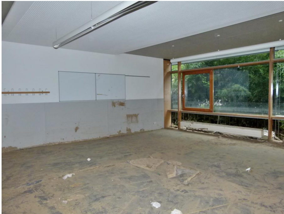
Foto 33 HS 2 - Unterrichtsraum mit Blick Richtung Nordosten
