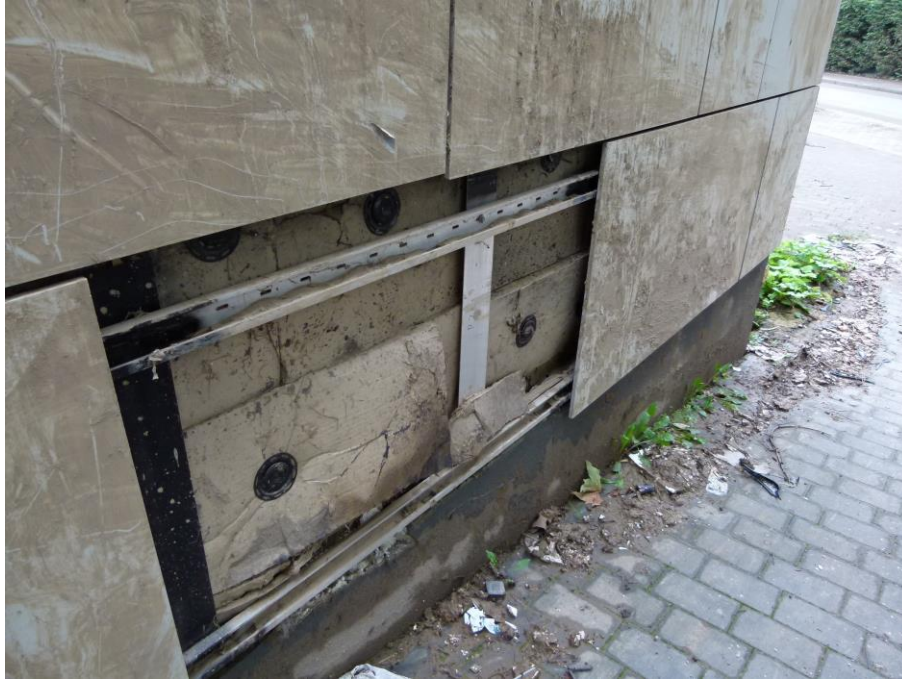
Foto 10 HS 4 - Detailaufnahme zur Fassadenunterkonstruktion
