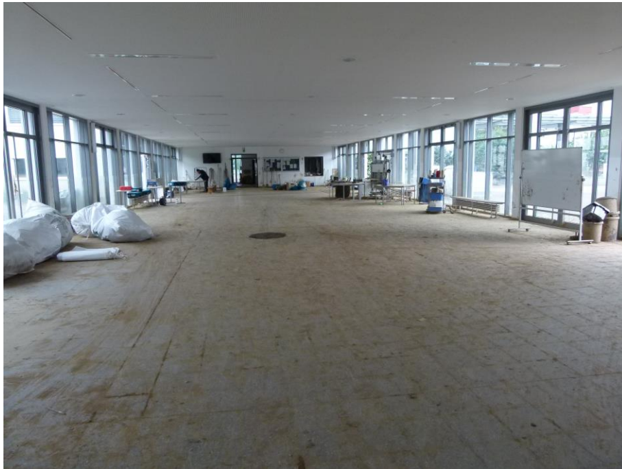
Foto 24 HS 1 - Pfosten-Riegel-Konstruktion Eingangshalle mit Blick Richtung Norden
