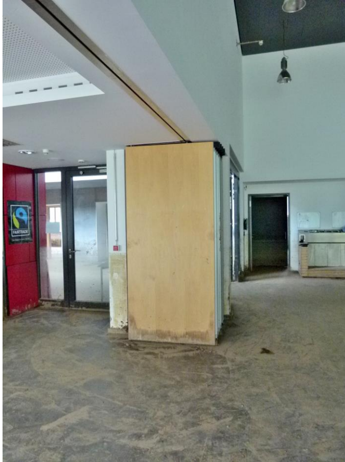
Foto 40 HS 4 - mobile Trennwand zwischen Bistro und Mensa
