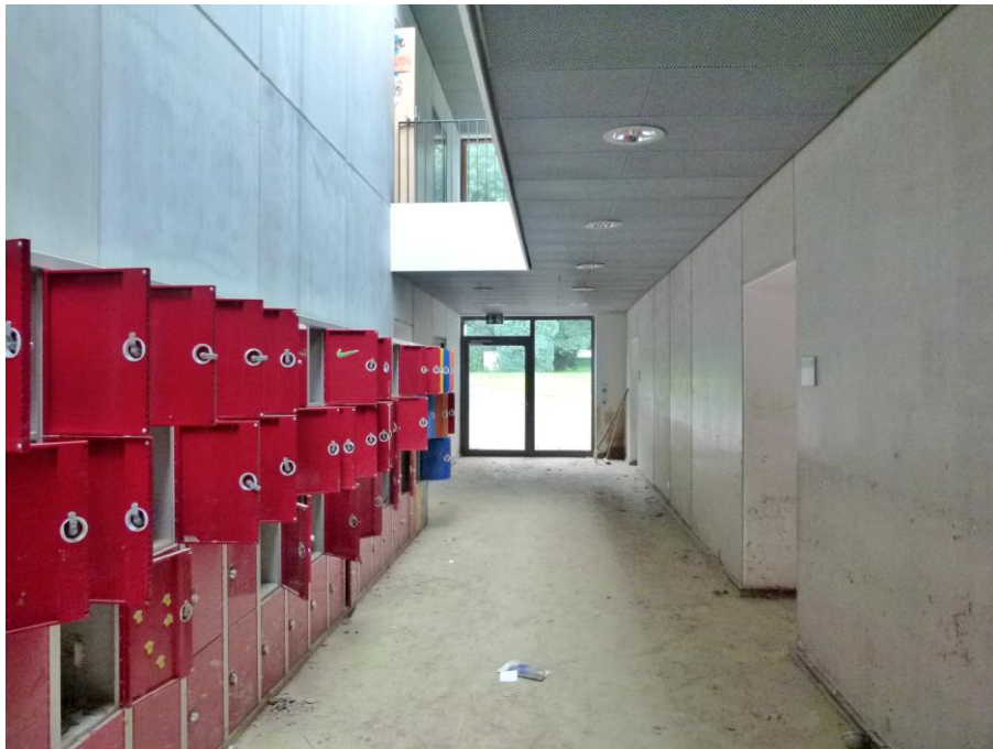
Foto 37 HS 4 - Flur mit Blick Richtung Süden
