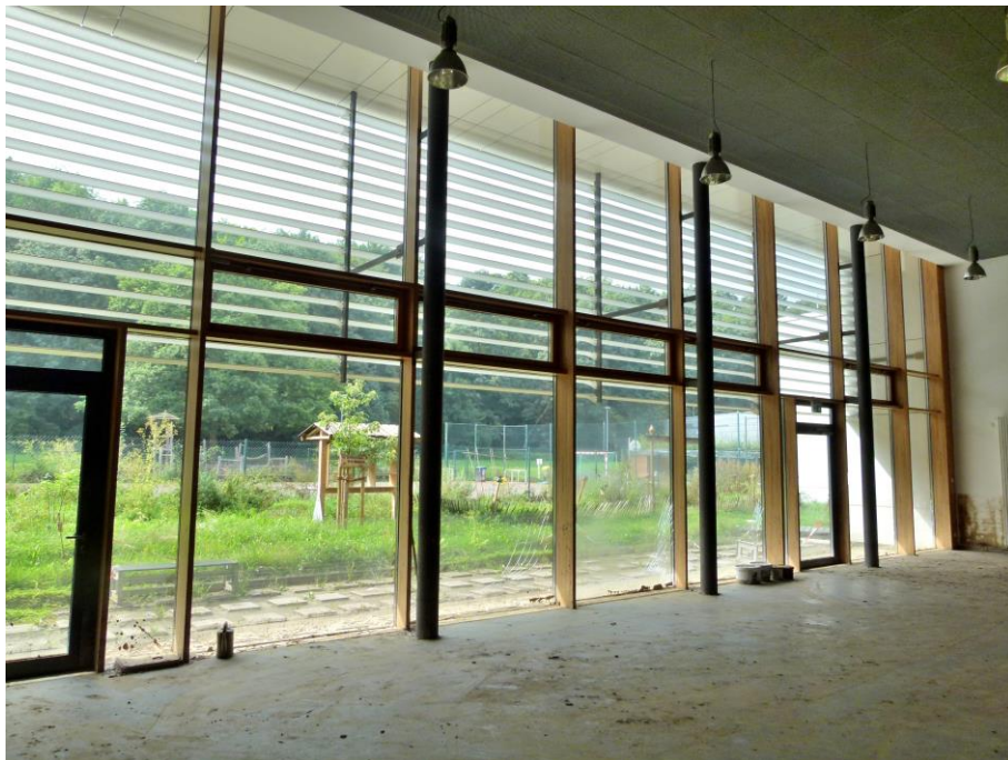
Foto 42 HS 4 - Pfosten-Riegel-Fassade Mensa (Südseite)
