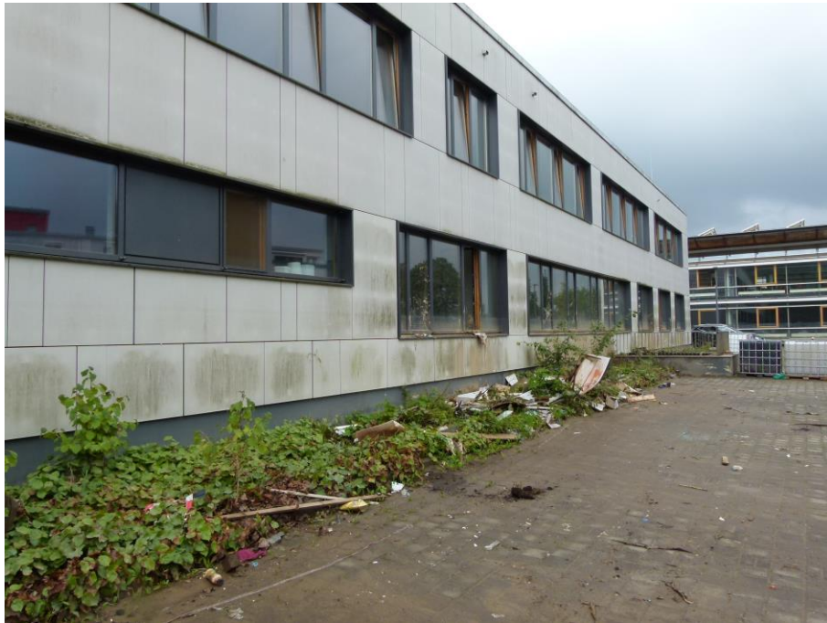
Foto 11 HS 4 - Nordfassade mit Blick Richtung Westen
