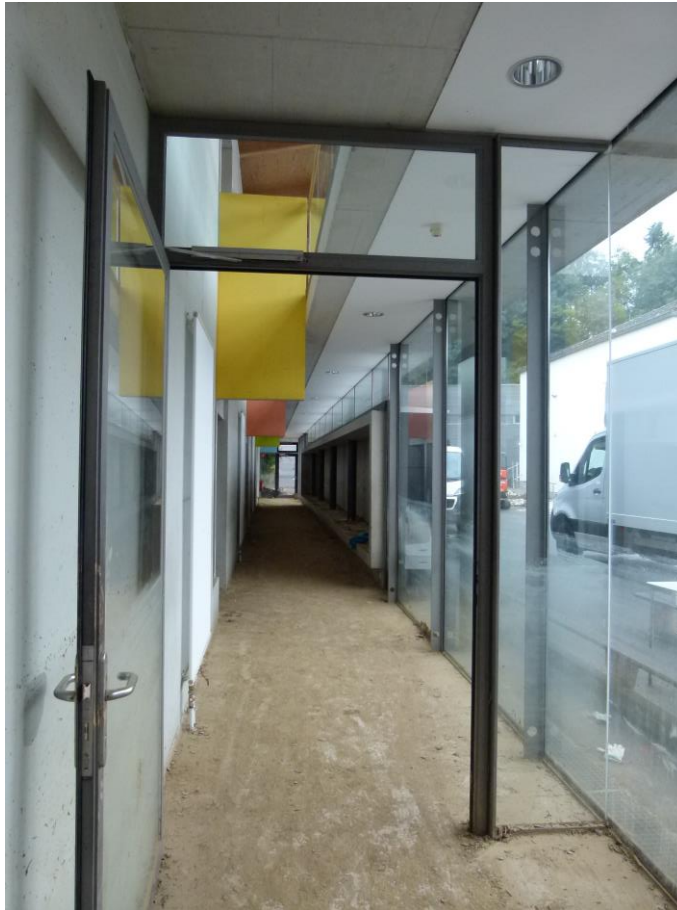
Foto 32 HS 2 - Flurzone mit Blick Richtung Süden
