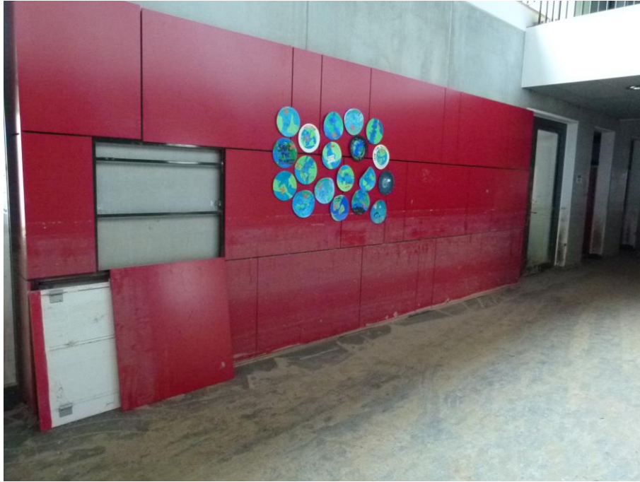
Foto 38 HS 4 Wandbekleidung an der Südwand der Flurzone
