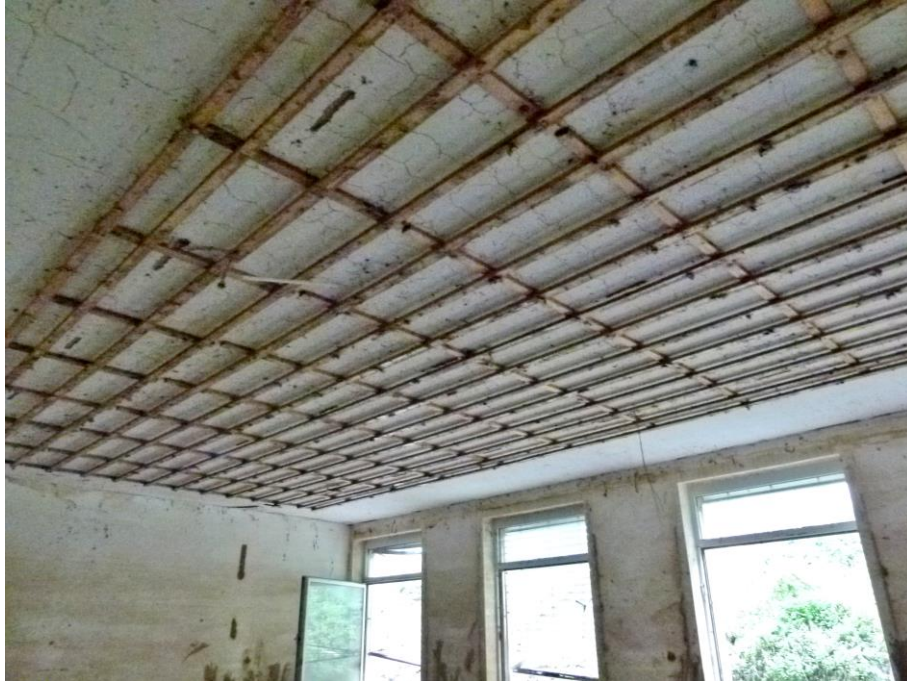
Foto 27 HS 1 - Abhängedecken in den Unterrichtsräumen
