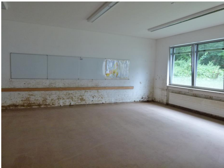
Foto 47 HS 3 - verputzte Trennwände zwischen den Unterrichtsräumen mit Blick Richtung Süden
