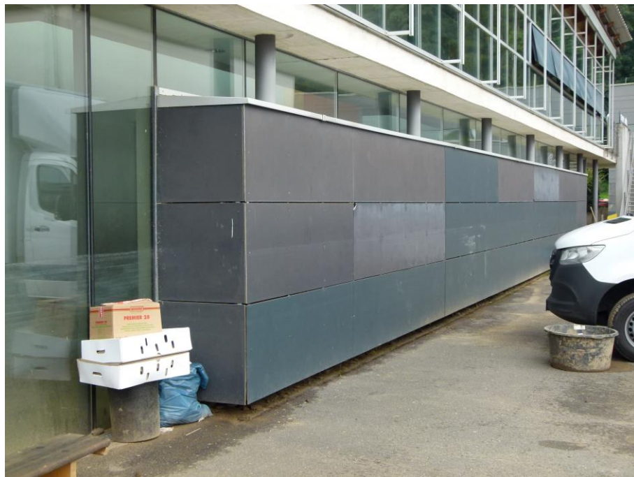
Foto 15 HS 2 - Westfassade Bereich Flure mit Blick Richtung Süden
