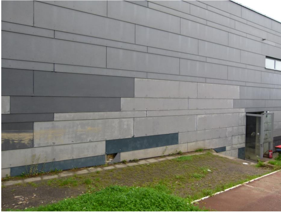
Foto 5 HS 3 - großformatige Platten Ostfassade
