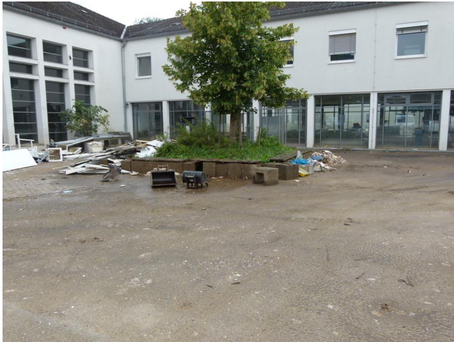
Foto 16 zerstörtes Pflanzbeet vor Haus 1
