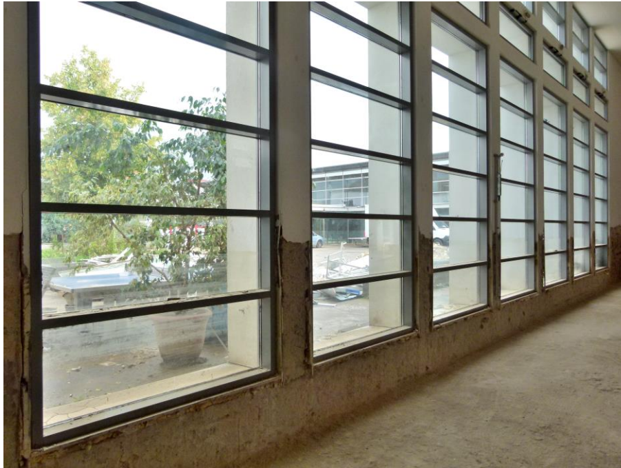
Foto 23 Pfosten-Riegel-Konstruktion Nordfassade
