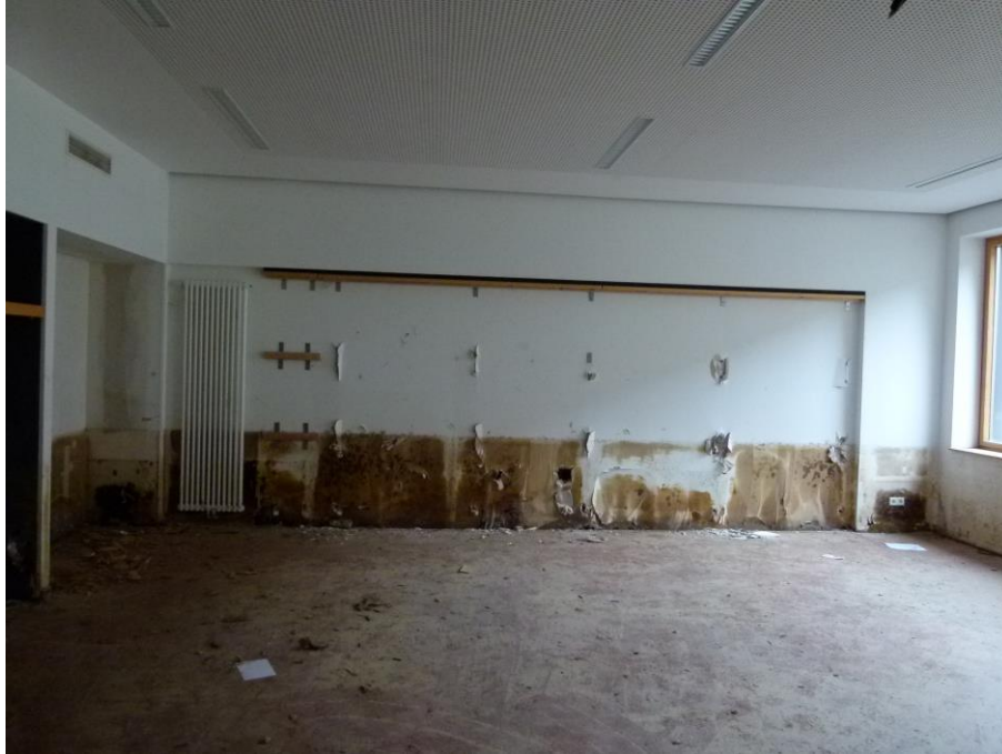
Foto 36 HS 4 - Trennwand aus Gipskarton zwischen den Klassenräumen mit Blick Richtung Süden
