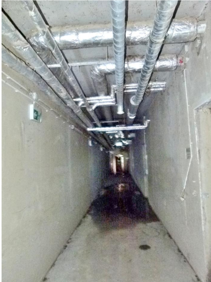
Foto 43 HS 4 - Flurzone Kellergeschoss mit Blick Richtung Westen
