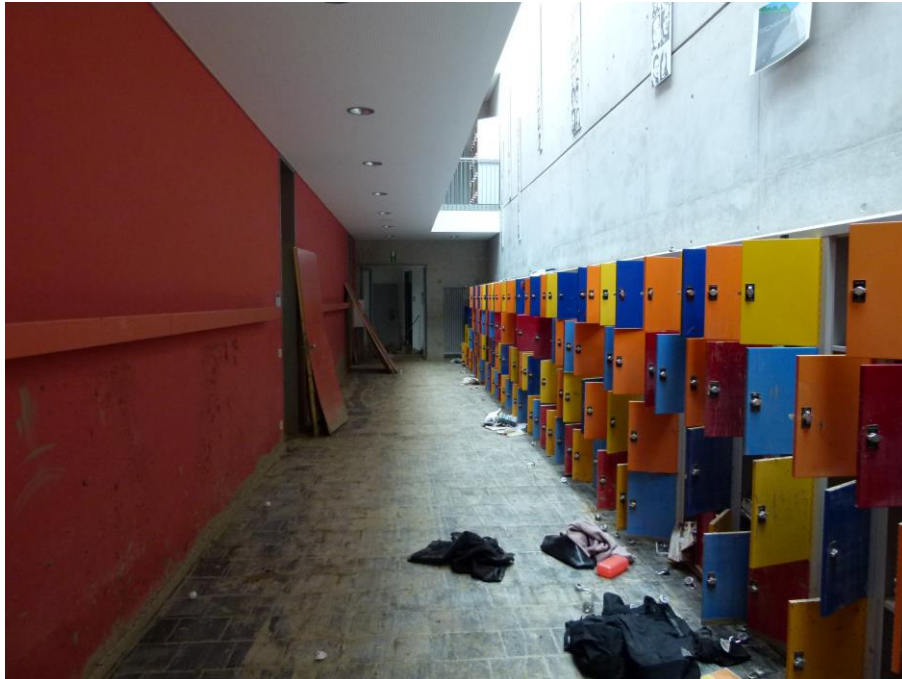
Foto 46 HS 3 - Flurzone vor den Unterrichtsräumen mit Blick Richtung Norden
