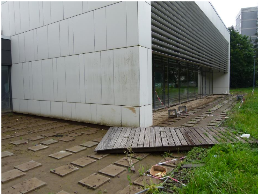
Foto 8 HS 4 - Südwestecke Mensa
