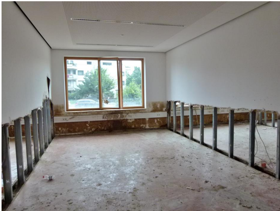
Foto 35 HS 4 - Nebenräume mit Blick Richtung Norden
