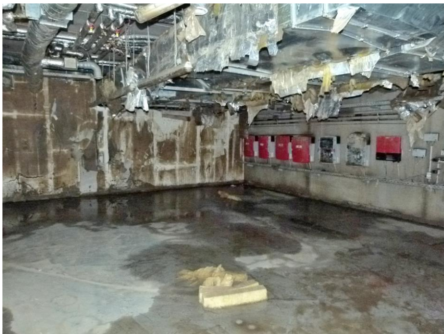
Foto 44 HS 4 - Lagerraum Untergeschoss mit Blick Richtung Nordwesten
