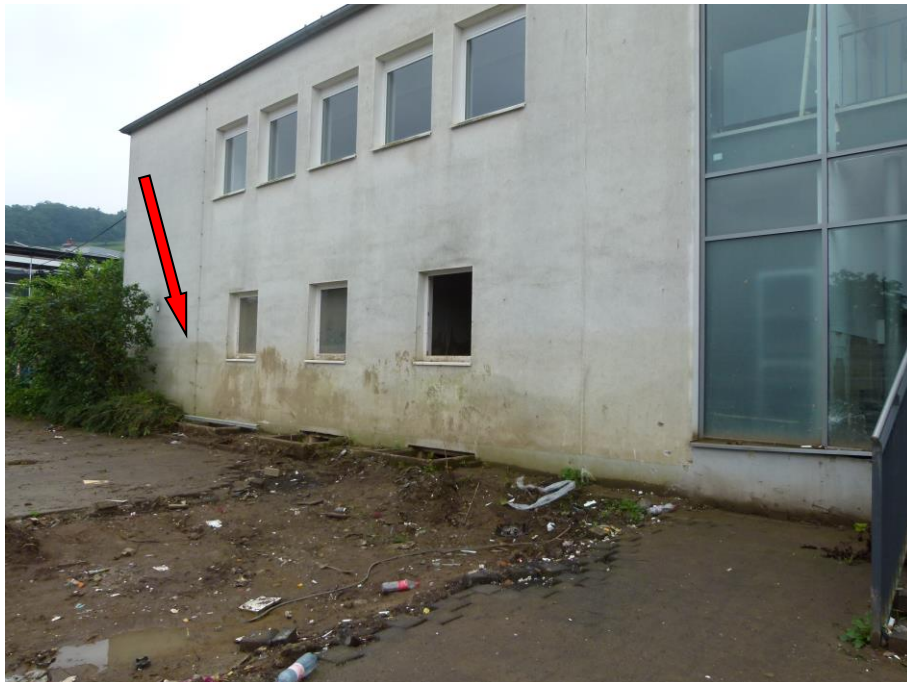
Foto 1 Nordfassade links neben dem Haupteingang
