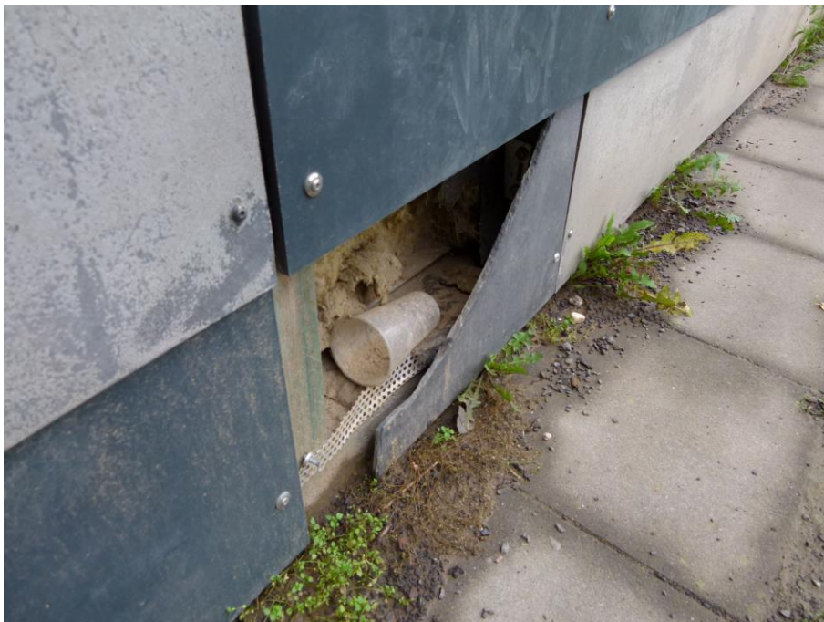
Foto 6 HS 3 - Konstruktionsaufbau Fassadenflächen
