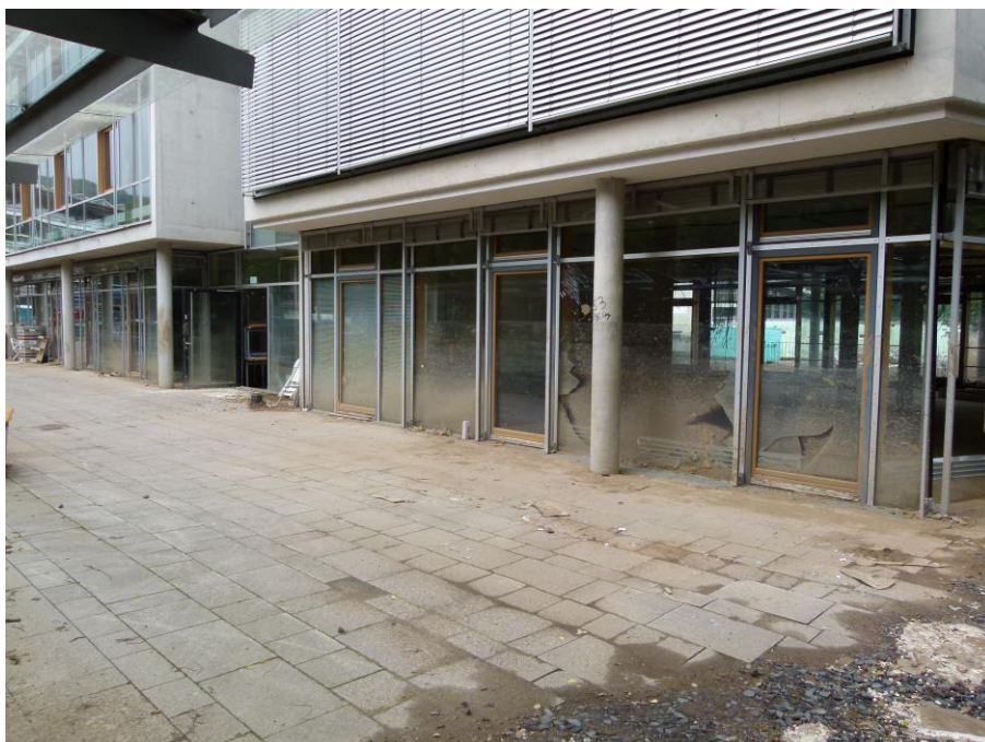
Foto 4 Ostfassade Nordflügel Achse A
