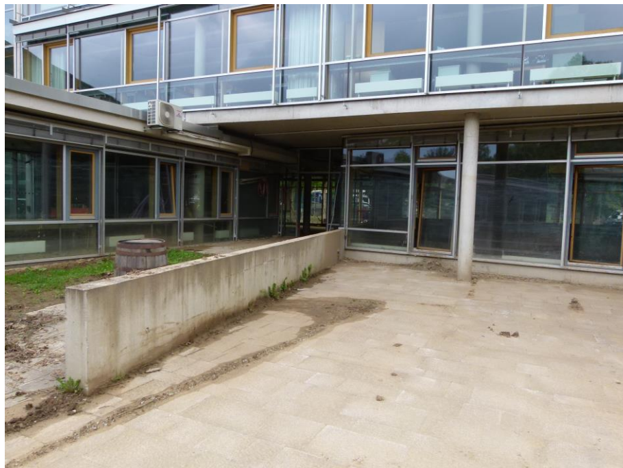
Foto 11 Fassade Bibliothek / Verwaltungstrakt mit Blick Richtung Norden
