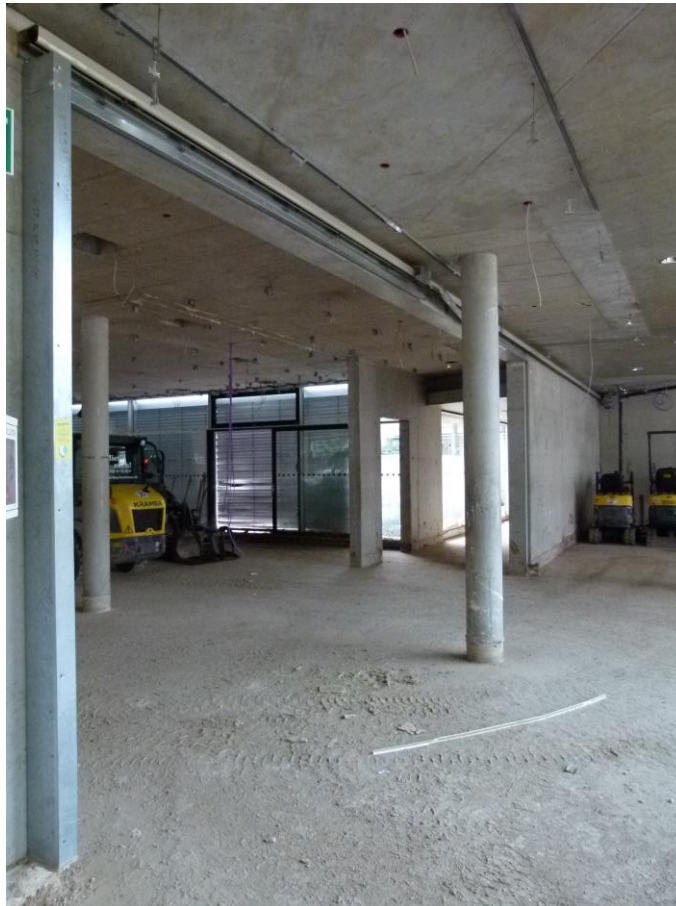
Foto 20 Lage des Brandschutz-Schiebtores
