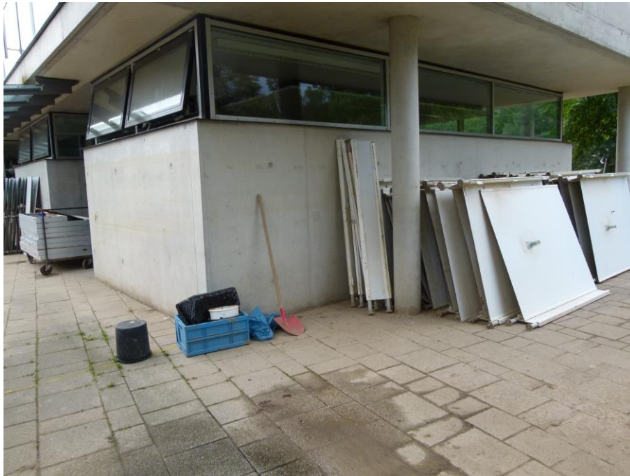
Foto 15 WC-Trakt Westflügel mit Blick Richtung Osten
