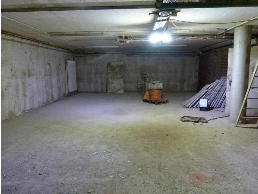
Foto 28 großer Kellerraum mit Blick Richtung Norden
