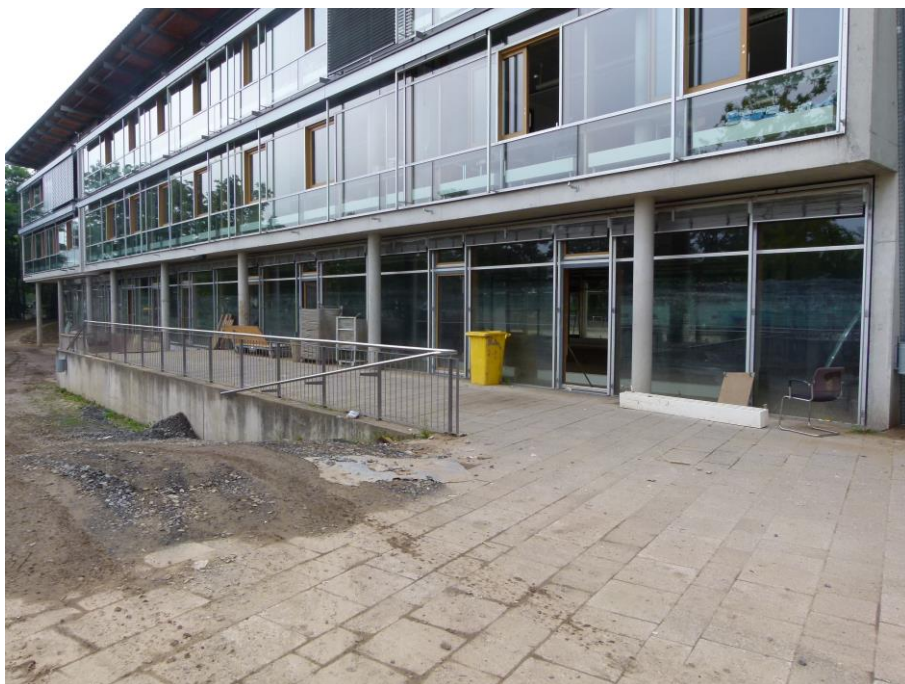
Foto 2 Pfosten-Riegel-Fassade Westseite Achse D
