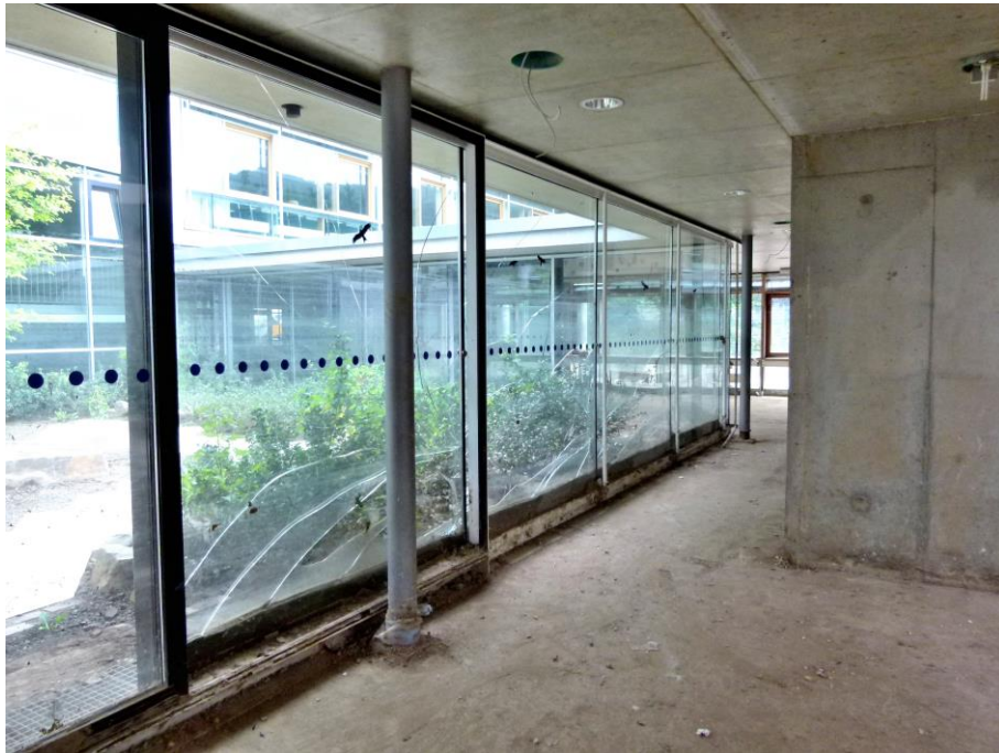
Foto 25 Fassade Innenhof mit Blick Richtung Osten
