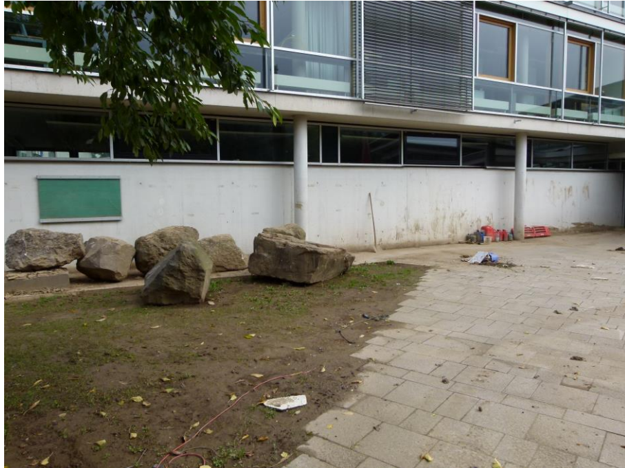
Foto 14 Südostfassade Westflügel Achse F mit Blick Richtung Norden
