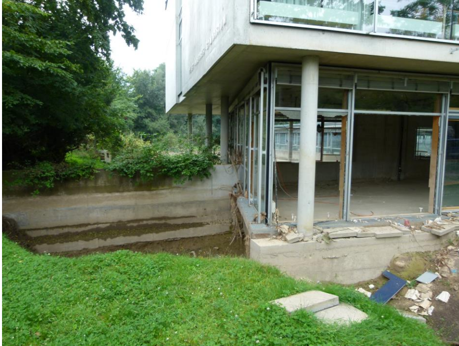
Foto 7 Detailaufnahme zur Nordostfassade Bereich Bibliothek
