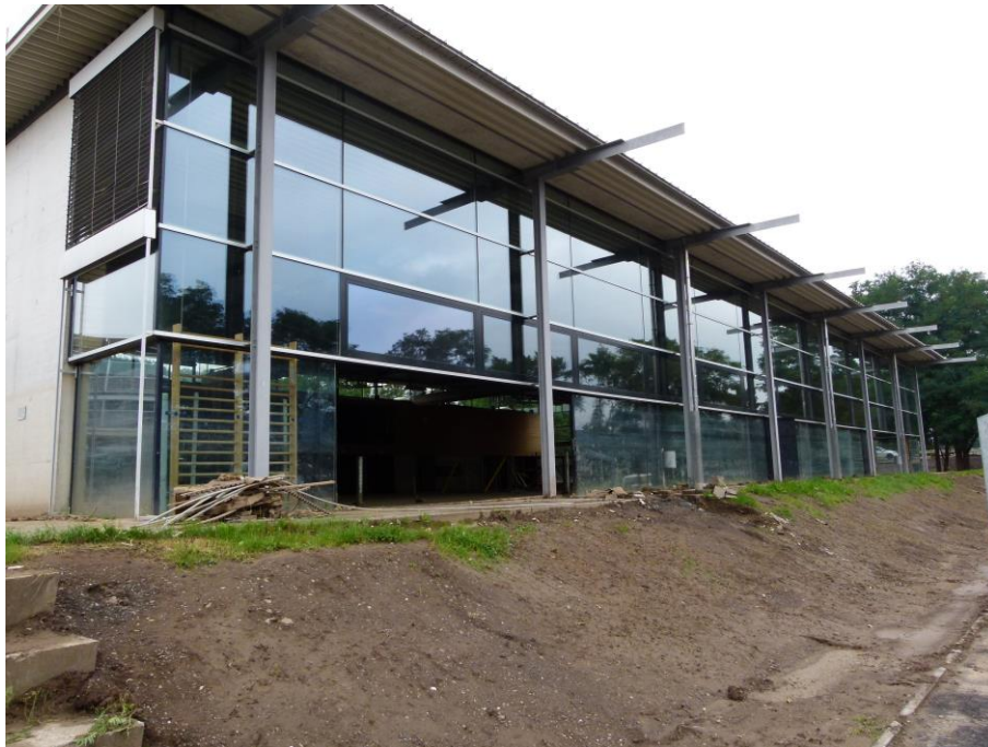
Foto 30 Nordwestfassade Sporthalle mit Blick Richtung Süden
