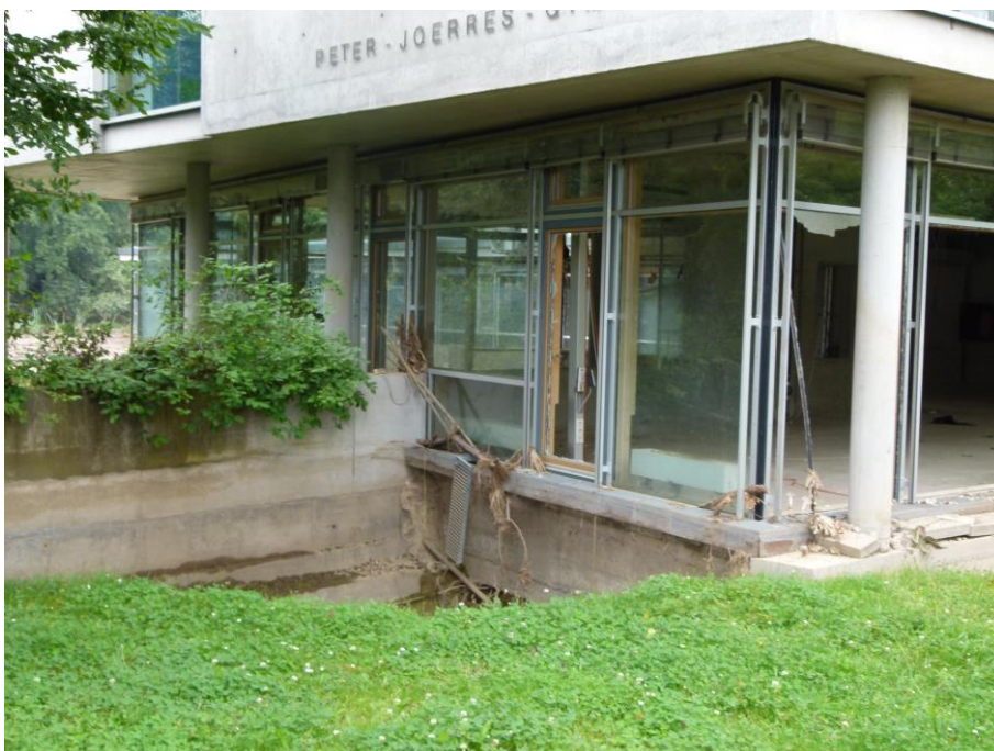
Foto 8 Südostfassade Südflügel Achse 1/N-K
