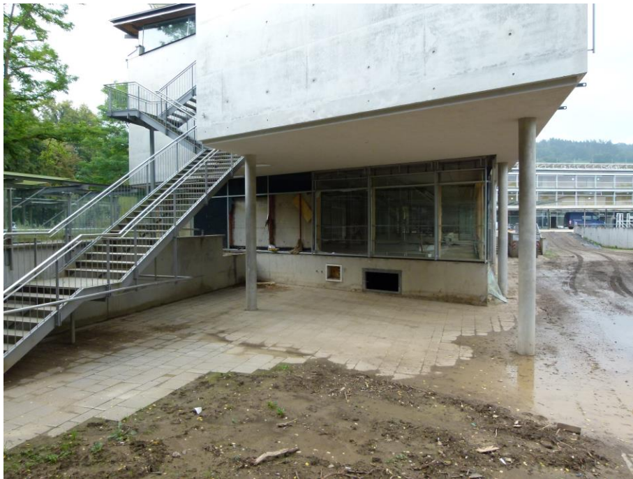
Foto 3 Pfosten-Riegel-Fassade Nordseite
