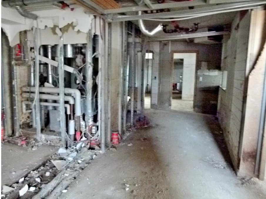
Foto 34 Trennwände als Ständerkonstruktion
