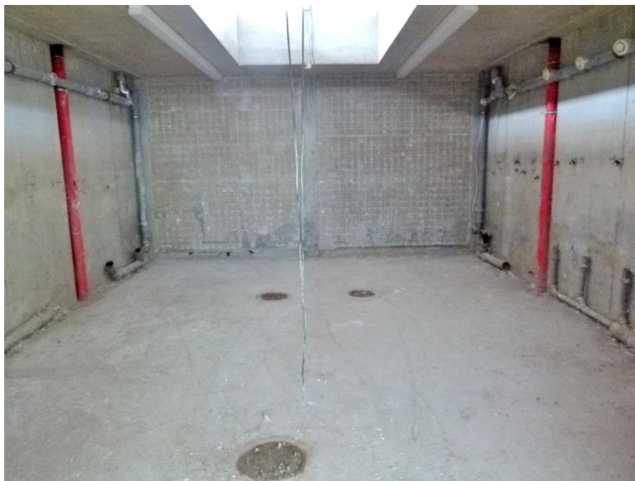
Foto 22 WC-Trakt mit Blick Richtung Süden
