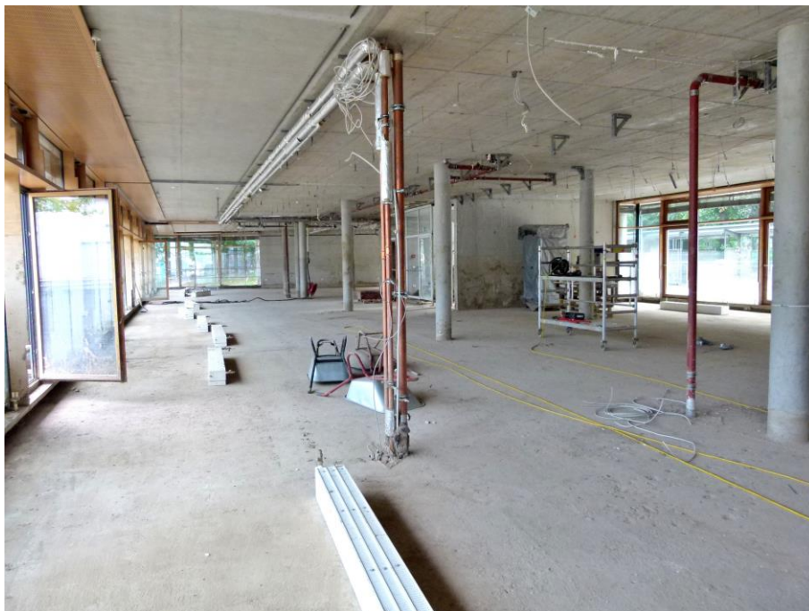
Foto 17 Innenbereich Nordflügel mit Blick Richtung Norden
