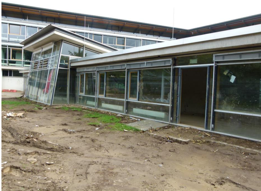
Foto 13 Südfassade Verwaltungstrakt bzw. Lehrerzimmer Achse G
