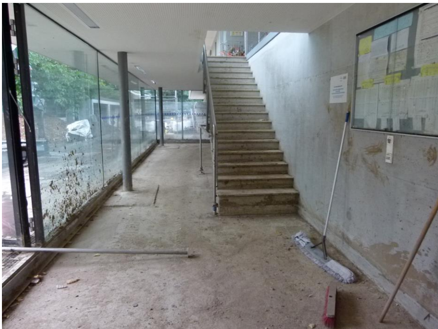
Foto 35 Foyerzone Sporthalle mit Blick Richtung Südwesten
