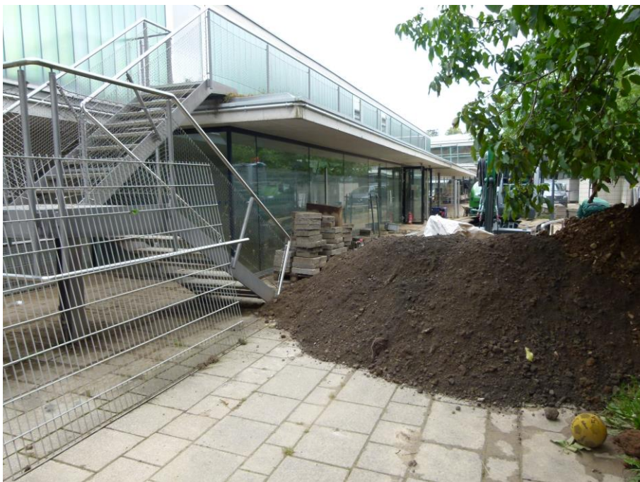
Foto 32 Südostfassade Sporthalle mit Blick Richtung Norden
