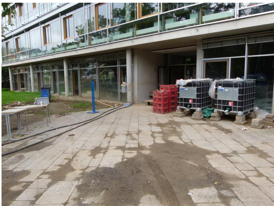
Foto 6 Nordostfassade Bibliothek Achse N
