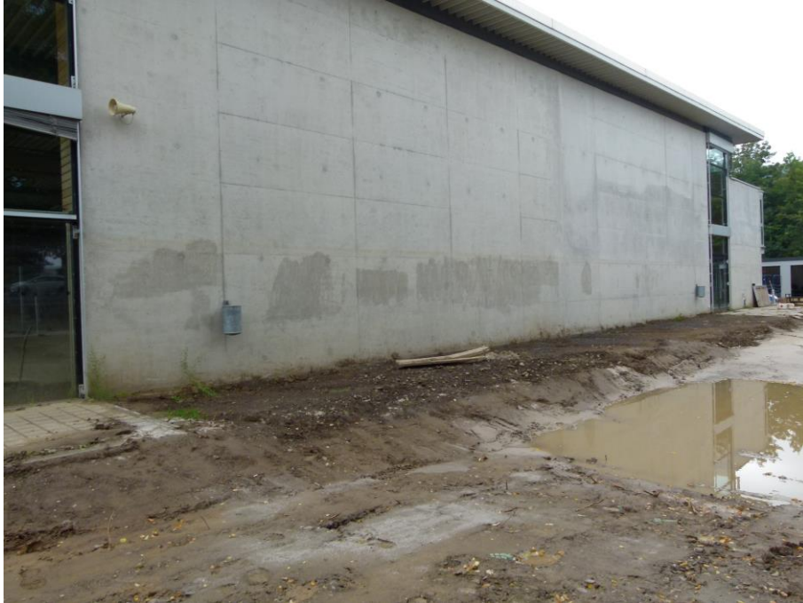
Foto 31 Südwestfassade Sporthalle mit Blick Richtung Osten
