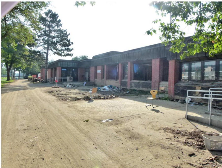
Foto 1 Nordfassade mit Blick Richtung Südosten
