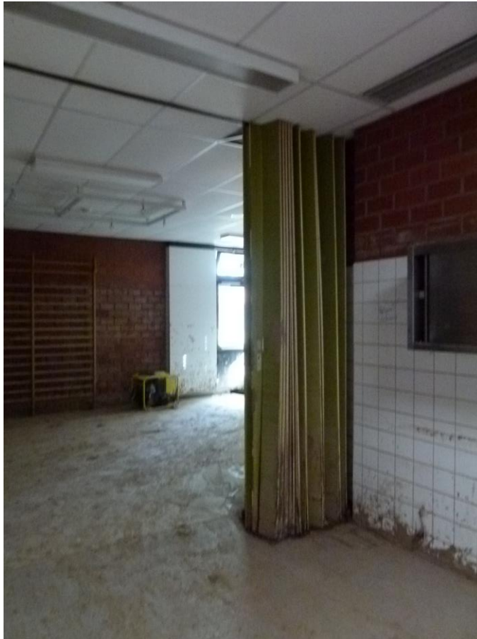
Foto 16 mobile Trennwand Ausgabe Gemeinschaftsraum mit Blick Richtung Norden
