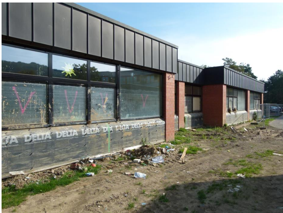
Foto 5 Südfassade Gebäudeteil 2013 mit Blick Richtung Nordosten
