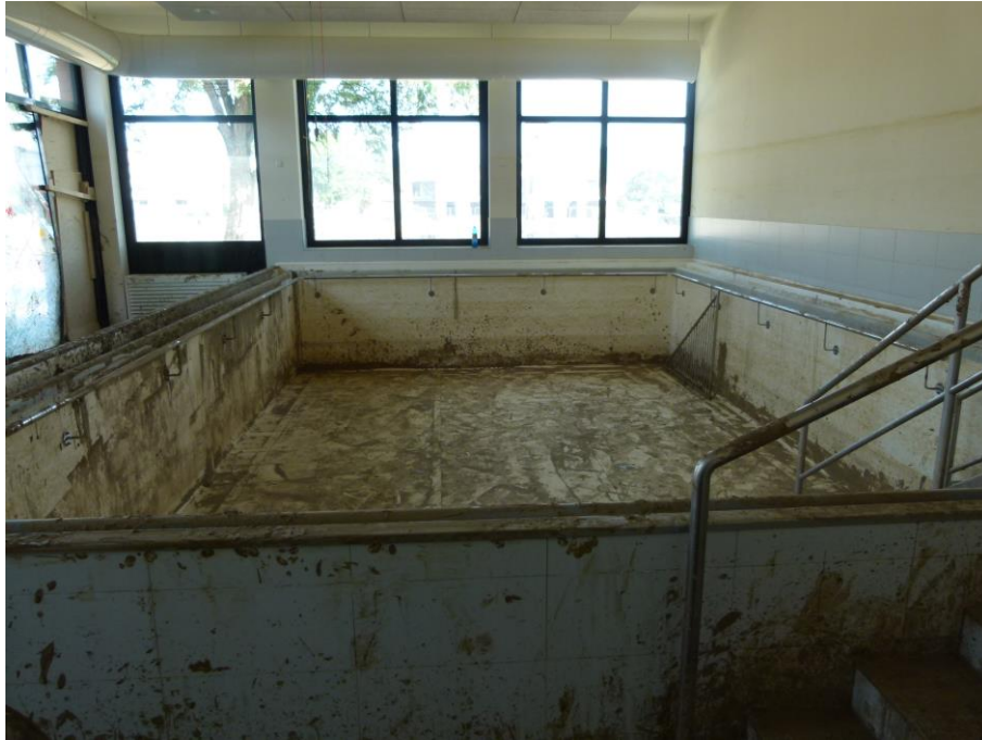
Foto 15 Becken Therapiebad mit Blick Richtung Norden
