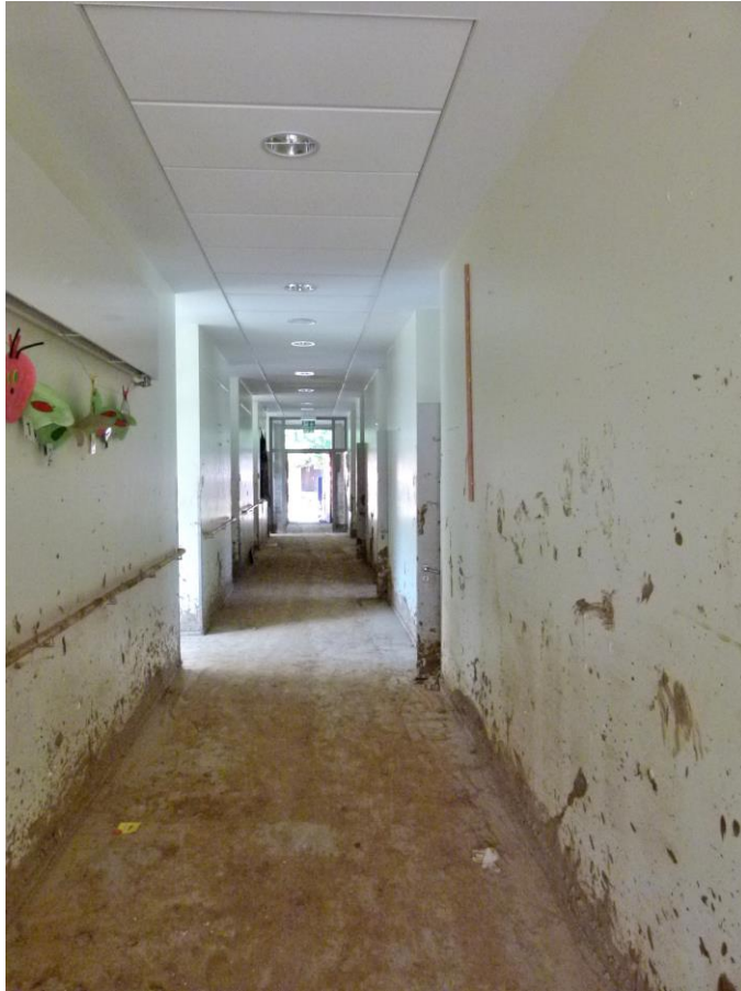
Foto 12 Flurzone Baukörper 2013 mit Blick Richtung Westen
