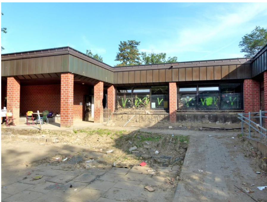
Foto 8 Südfassade Gebäudeteil 1971 am Anschluss zum Verbindungsgang mit Blick Richtung Norden
