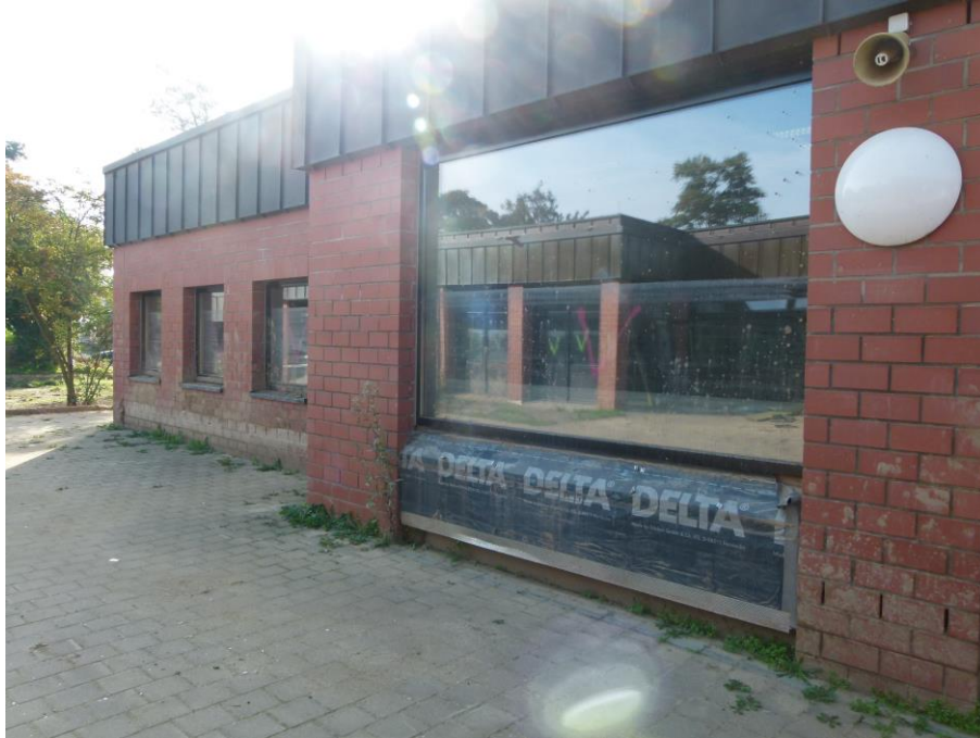
Foto 4 Nordfassade Gebäudeteil 2013 mit Blick Richtung Südosten
