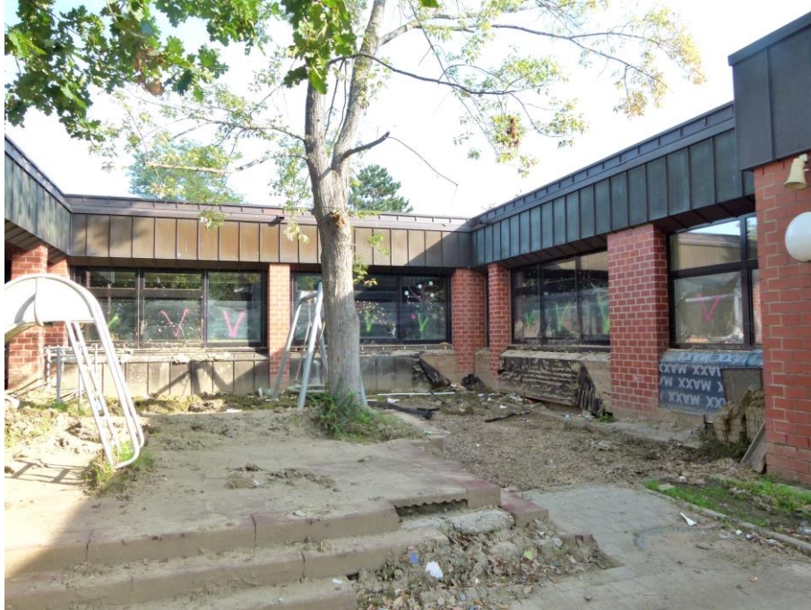
Foto 6 Südfassade Gebäudeteil 1971 am Anschluss zur Erweiterung 2013 mit Blick Richtung Norden
