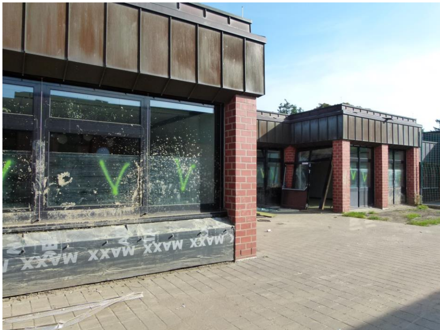
Foto 3 Südfassade Gebäudeteil 1971 mit Blick Richtung Nordosten
