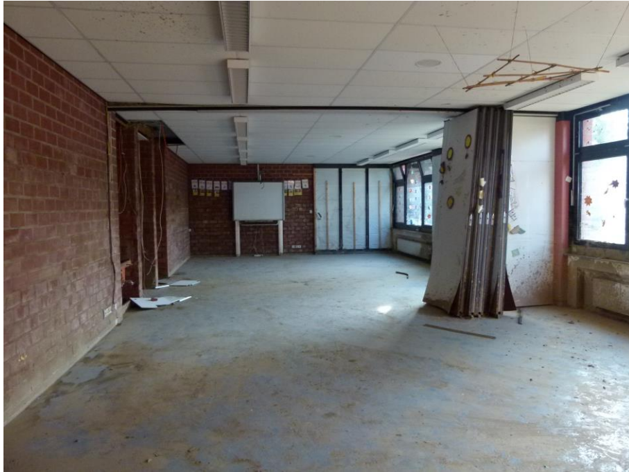
Foto 16 mobile Trennwand zwischen zwei Klassenräumen
