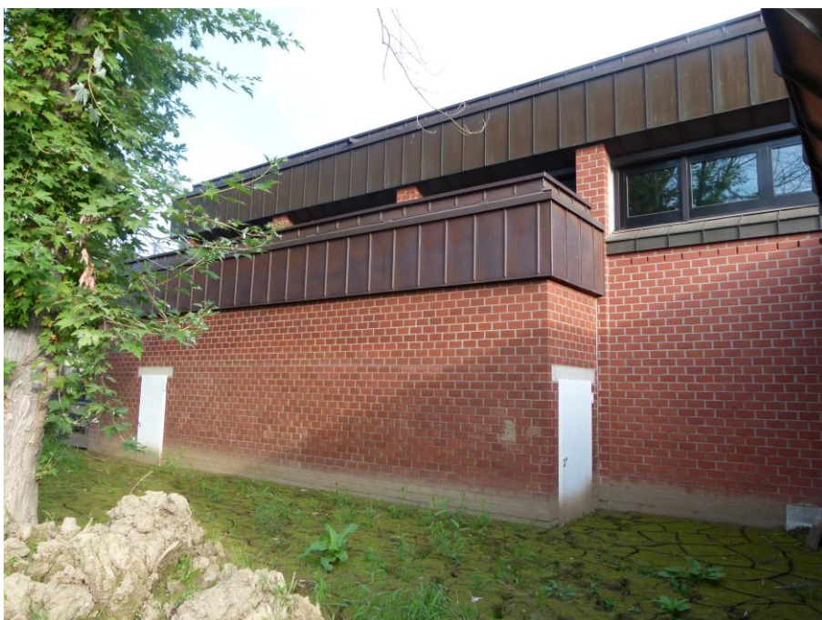
Foto 5 Fluchttreppe Südseite mit Blick Richtung Nordwesten
