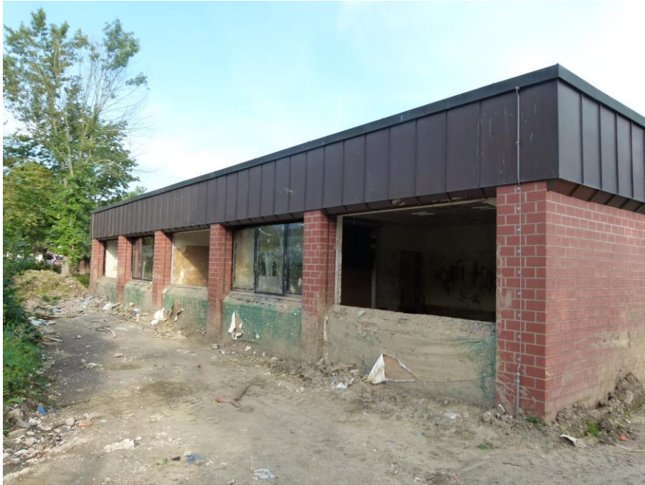
Foto 6 Schulerweiterung 2004 mit Blick auf Südfassade
