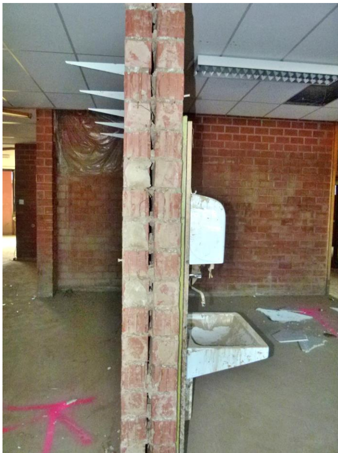
Foto 13 zweischalige Wand zwischen zwei Räumen
