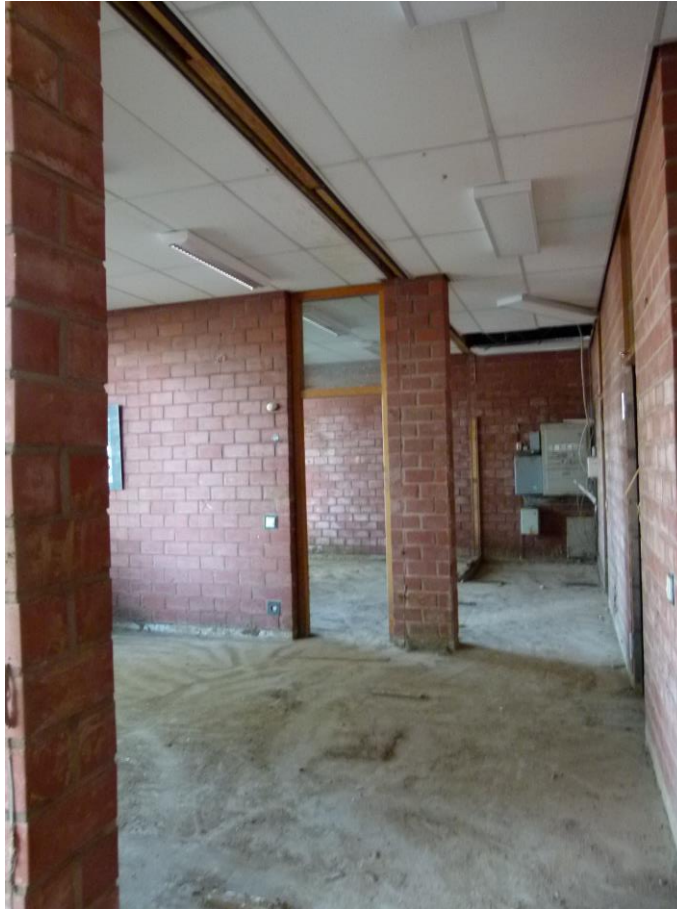
Foto 15 Verwaltungstrakt Bereich Einzelbüros mit Blick Richtung Norden
