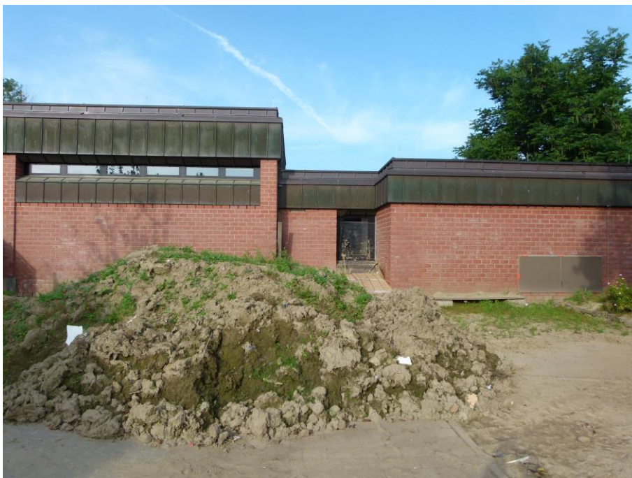
Foto 7 Ostfassade Bereich Gymnastikhalle bzw. Umkleide
