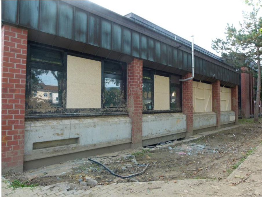
Foto 2 Westfassade eingeschossiger Trakt mit Blick Richtung Südosten
