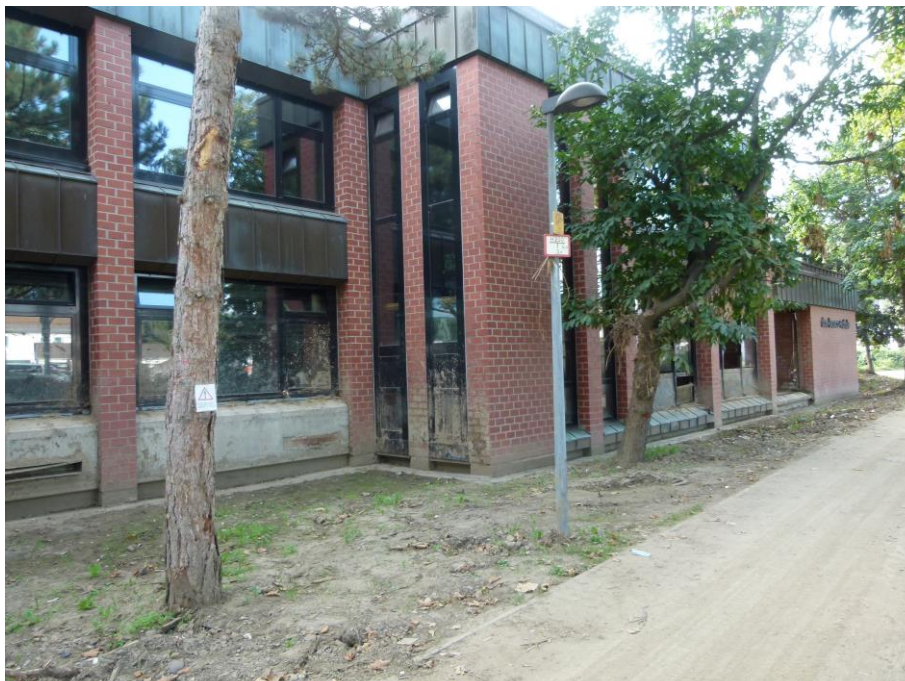
Foto 3 Westfassade zweigeschossiger Trakt mit Blick Richtung Südosten
