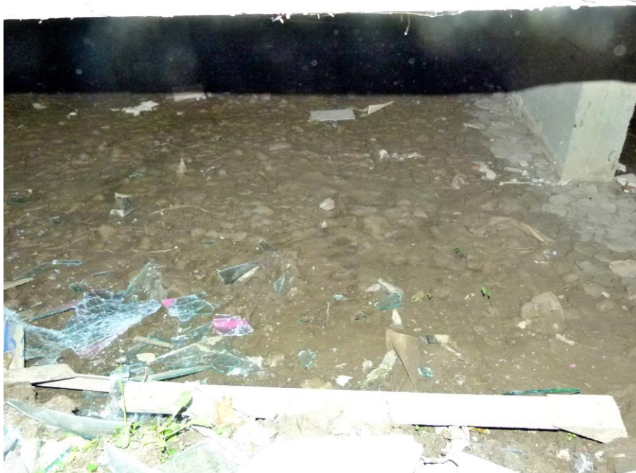
Foto 11 Zustand Kriechkeller mit Blick vom westlichen Lichtschacht Richtung Osten
