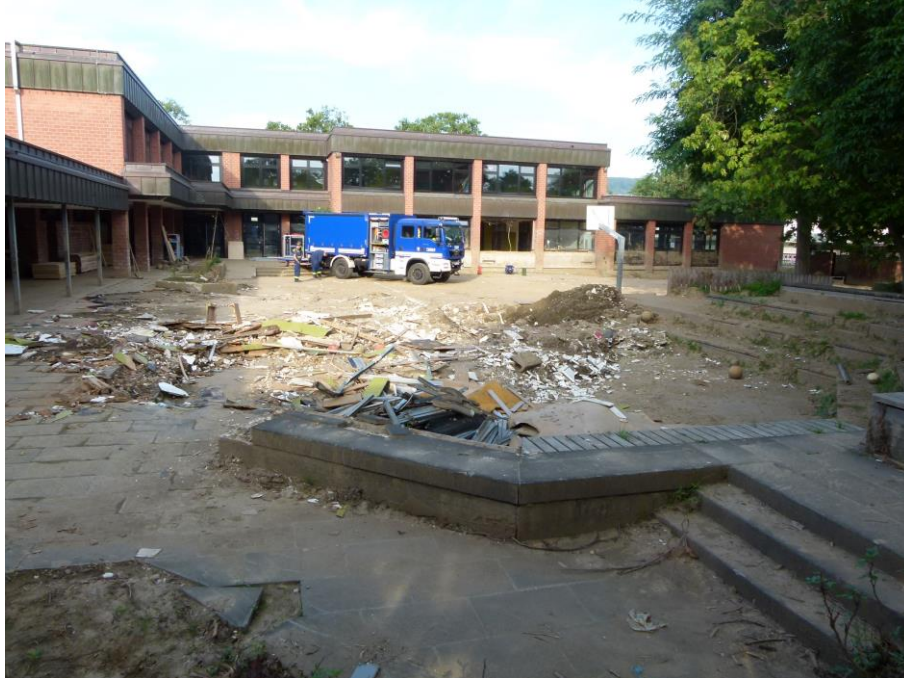
Foto 10 Zustand des Innenhofes mit Blick Richtung Westen
