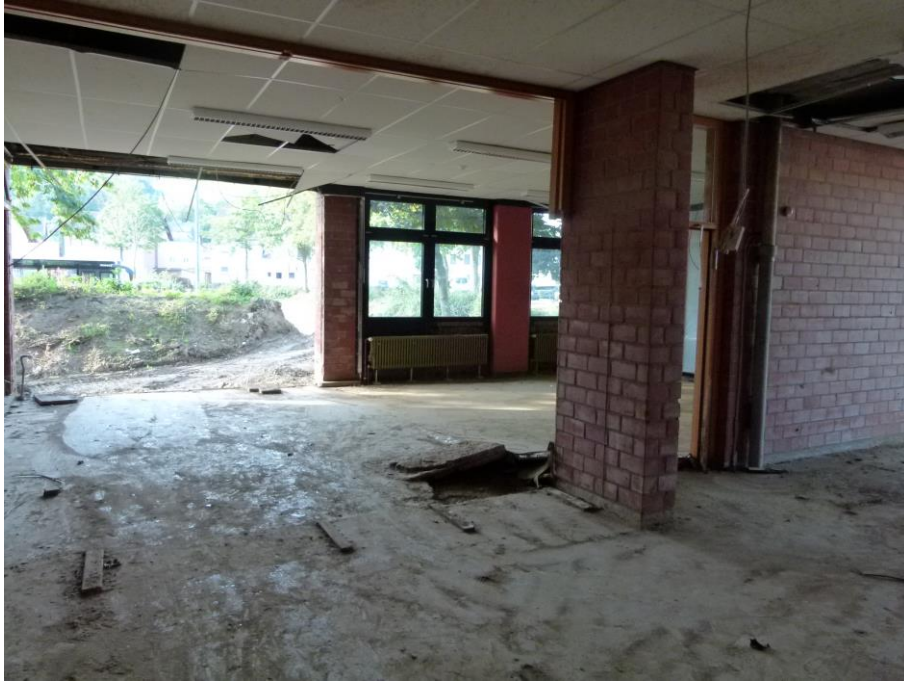
Foto 14 Verwaltungstrakt mit Blick Richtung Südwesten
