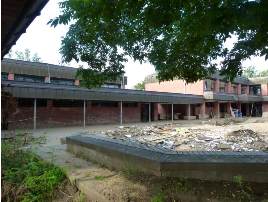
Foto 8 Nordfassade / Nebenraumtrakt vor der Sporthalle
