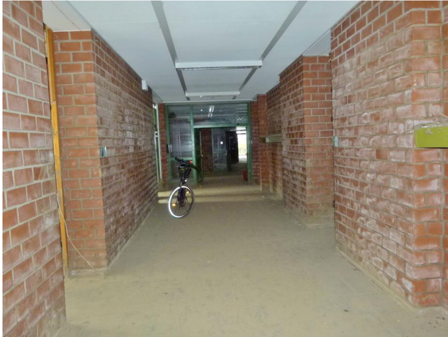
Foto 12 Flur des nördlichen Gebäudeflügels mit Blick Richtung Süden
