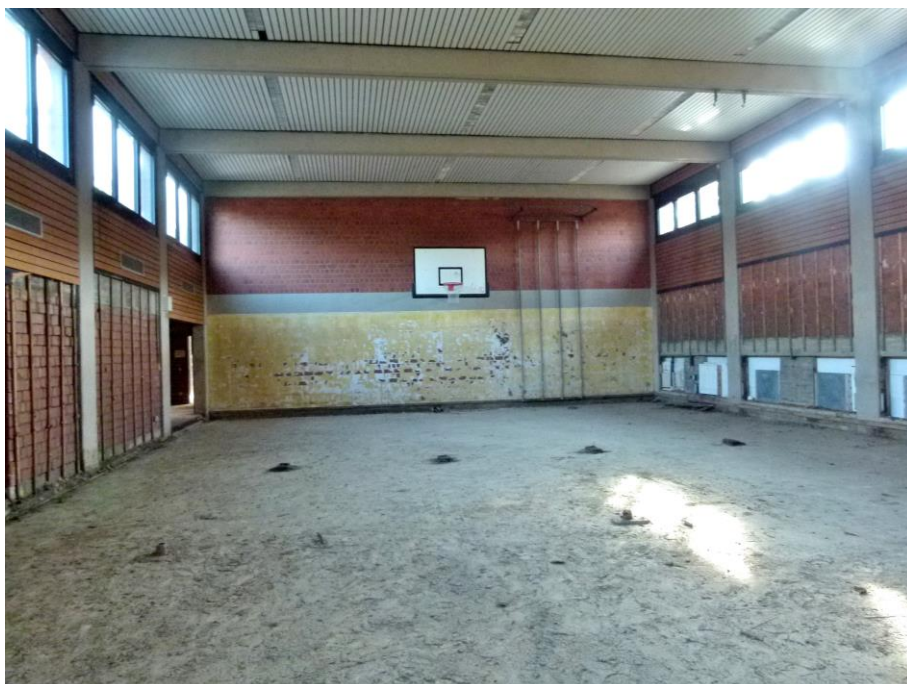
Foto 17 Sporthalle mit Blick Richtung Osten
