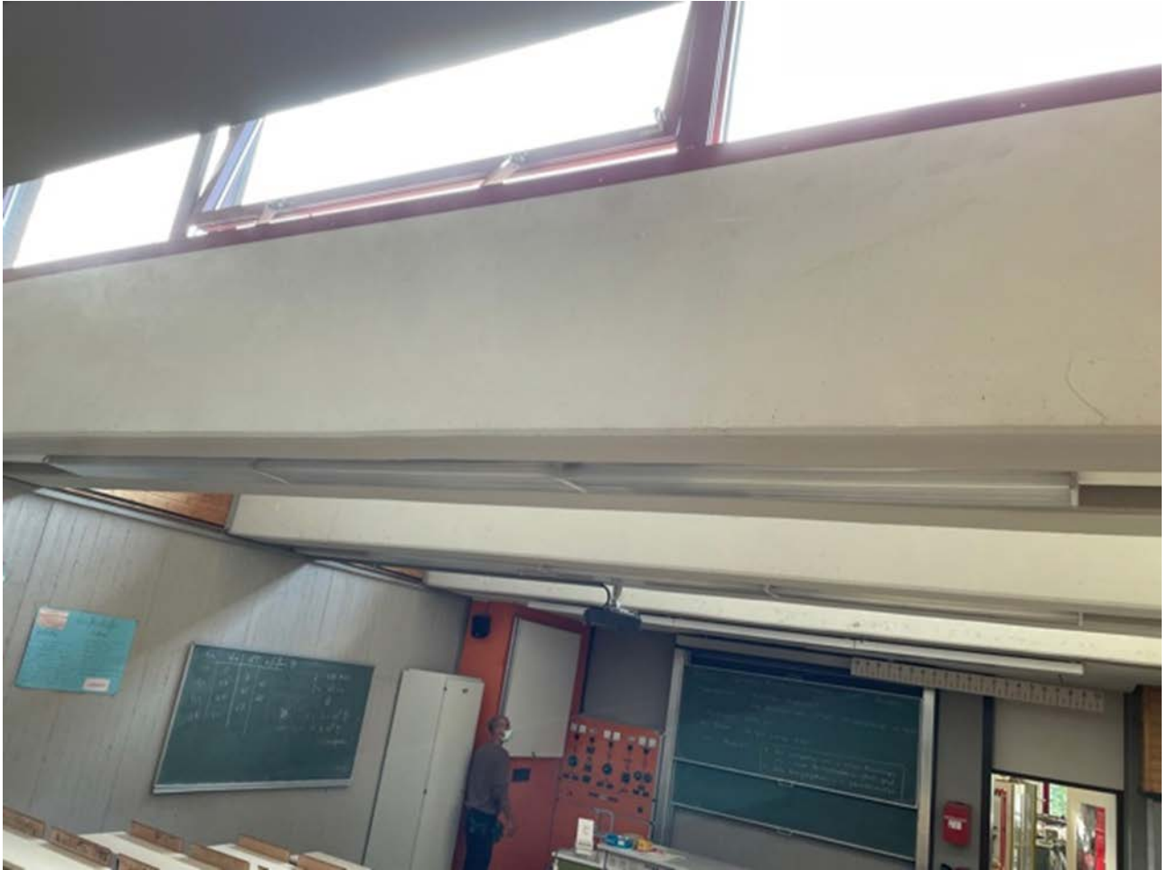
Abb.14: Innenliegender Physikraum, der nur über die Oberlichter be- und entlüftet wird.
