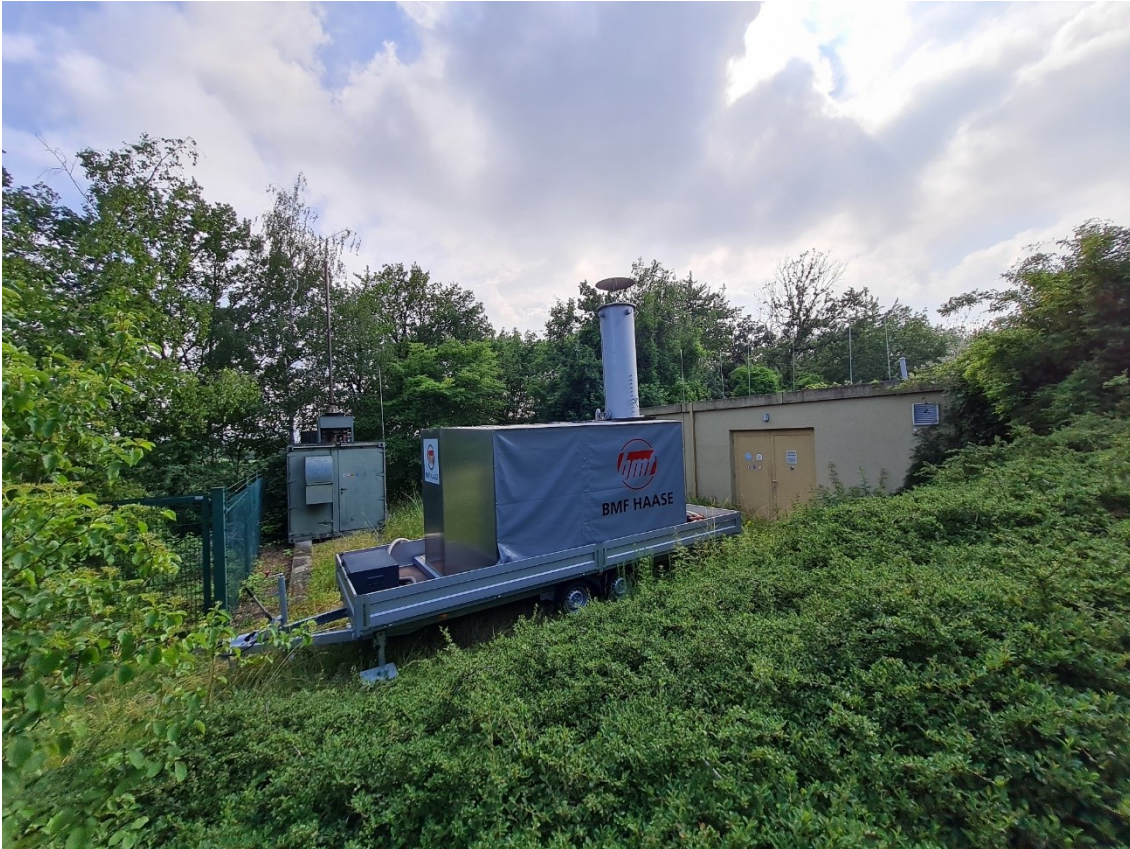
Abb. 3: Deponie Brohl-Lützing, im Vordergrund das mobile Mietfackelsystem für Absaugversuche, im Hintergrund die alte Fackel, BHKW und Verdichterstation
