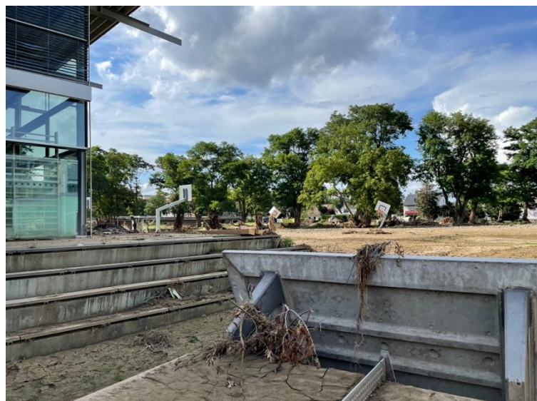
Abbildung 7: Peter-Joerres-Gymnasium Ahrweiler, Juli 2021 mit Hochwassermarken in der Glasscheibe
