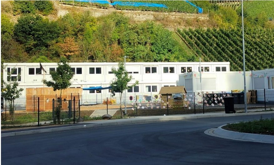
Foto: Provisorische Kita und Grundschule Dernau
