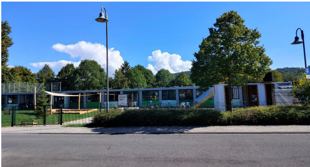
Foto: Provisorische Kita St. Mauritius in Heimersheim
