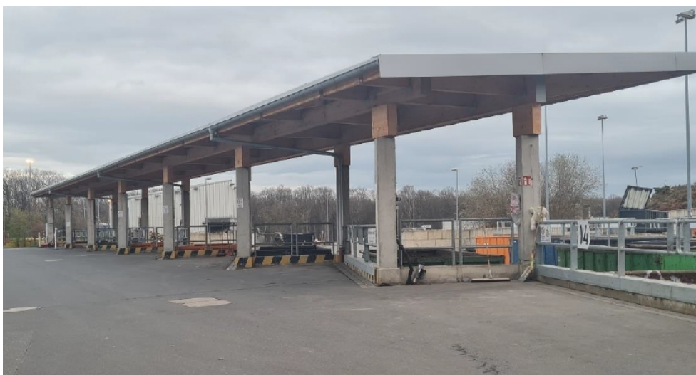
Abb. Überdachung Wertstofframpe
