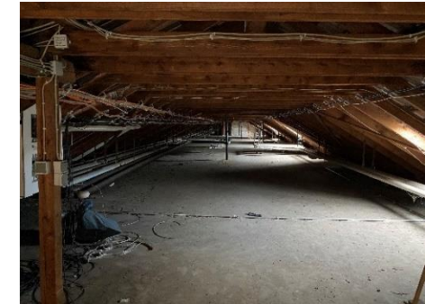
Abbildung Dachraum Are-Gymnasium (Altbau)
