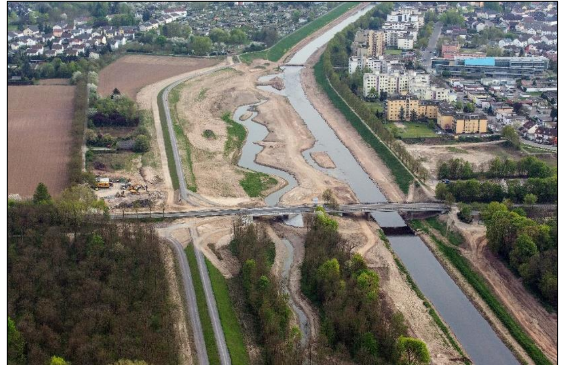
Dammrückverlegung / Gewässerumgestaltung Murg
