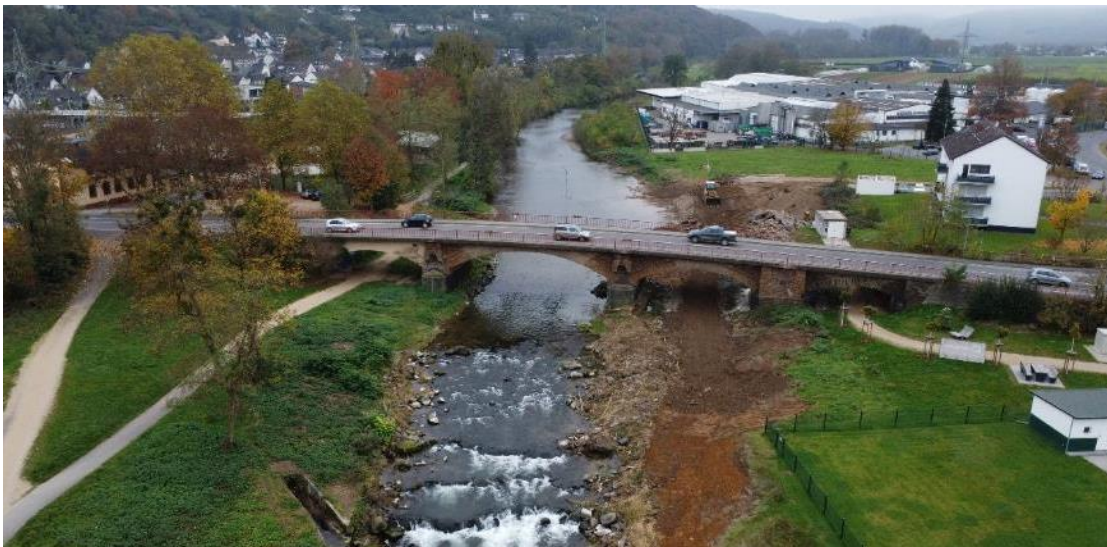
Bild: Brücke Kölner Straße in Sinzig, nach Baubeginn im November 2024
