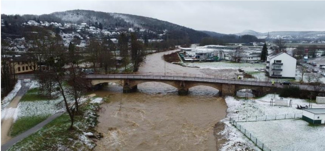
Bild: Brücke Kölner Straße in Sinzig, nach Fertigstellung bei Hochwasser im Januar 2025
